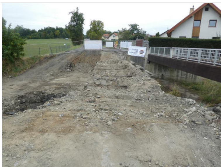
Pohled na most proti směru staničení.
