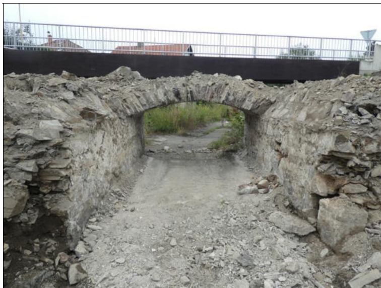
3. mostní otvor zprava.
