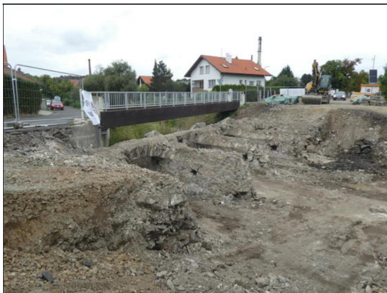
Pohled na most ve směru staničení.
