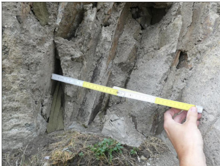
Klenební pás ve 2. poli - odbouraná část zprava.
