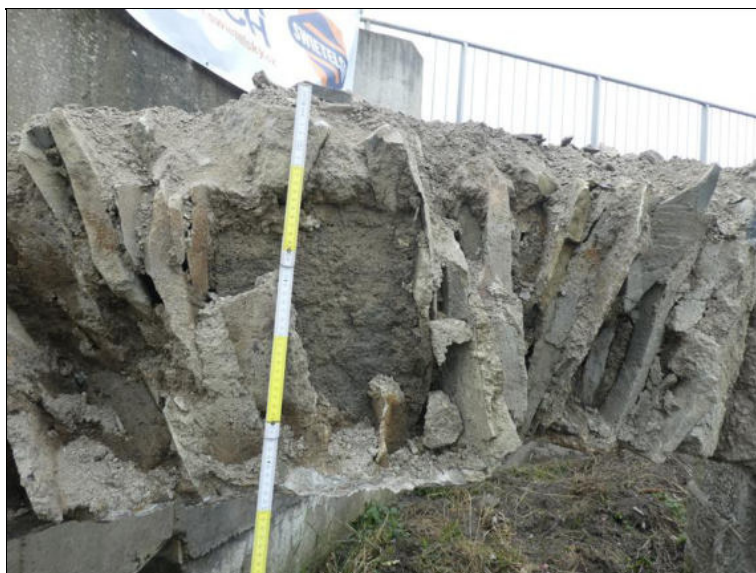
Klenební pás v 1. poli - odbouraná část zprava.
