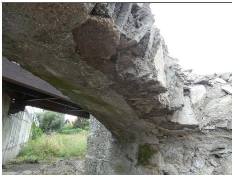
Podhled klenebního pásu v 1. poli - odbouraná část zprava.
