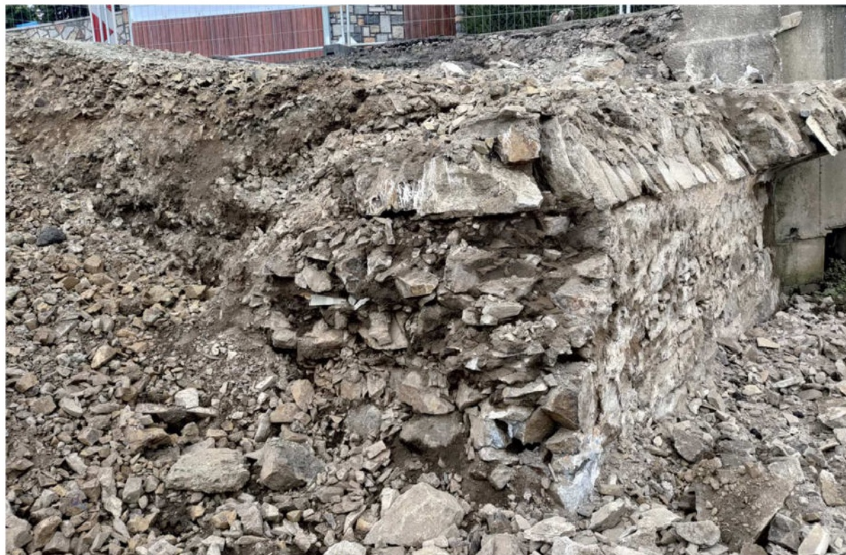
Obr. 3 – příčný řez opěrou O1
