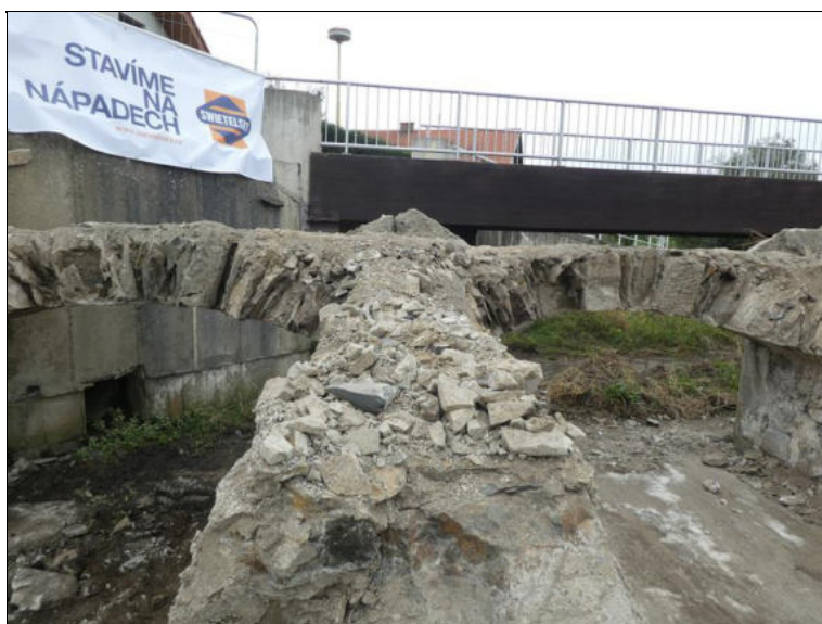
Částečně odbouraný dřík P2 zprava.
