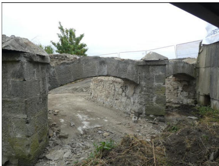
Pohled na P2, P3 a klenební pás ve 2. poli zleva.
