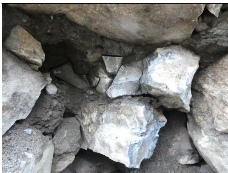
Pohled do sondy na OP1.
