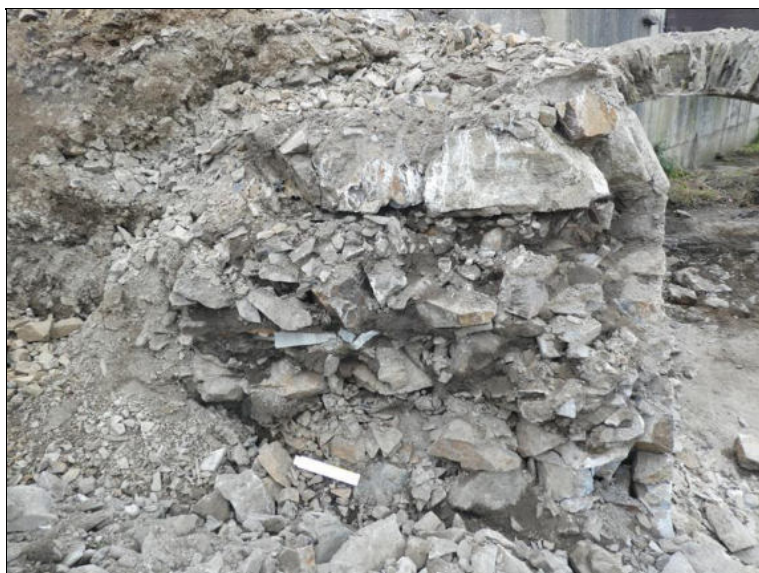
Částečně odbouraný dřík OP1 zleva.
