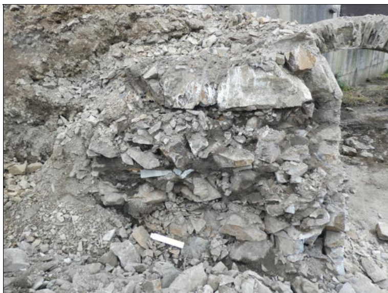
Částečně odbouraný dřík OP1 zleva.
