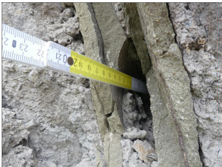
Kaverna v klenebním pásu 3. pole.
