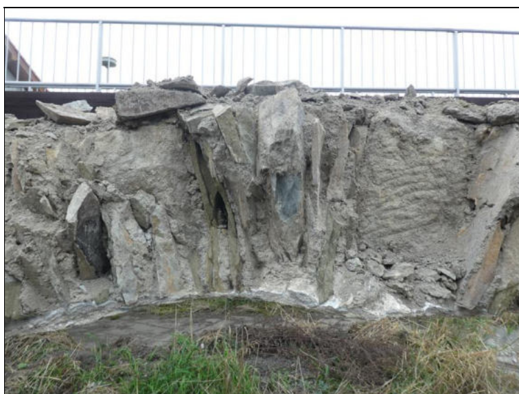
Klenební pás ve 3. poli - odbouraná část zprava.
