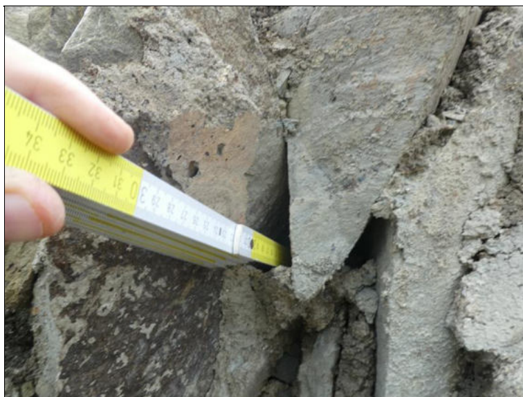
Kaverna v klenebním pásu 1. pole.
