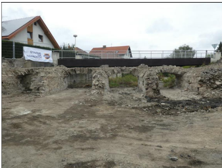
Pohled na most zprava.
