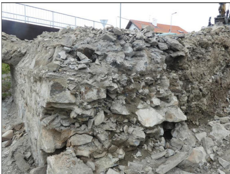
Částečně odbouraný dřík OP5 zprava.
