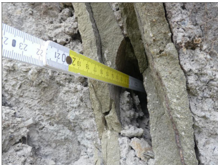
Kaverna v klenebním pásu 3. pole.
