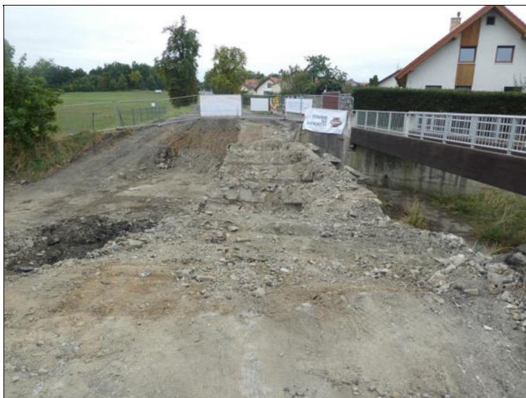
Pohled na most proti směru staničení.
