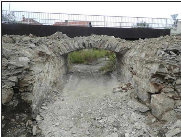
3. mostní otvor zprava.
