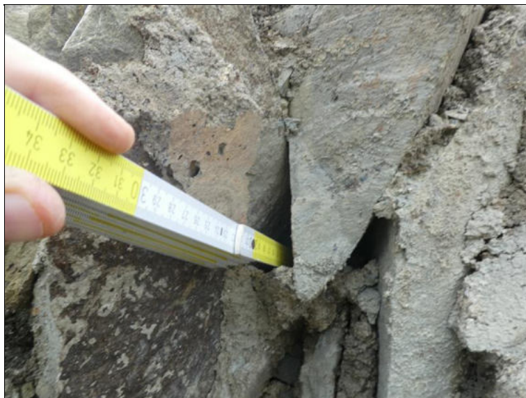
Kaverna v klenebním pásu 1. pole.
