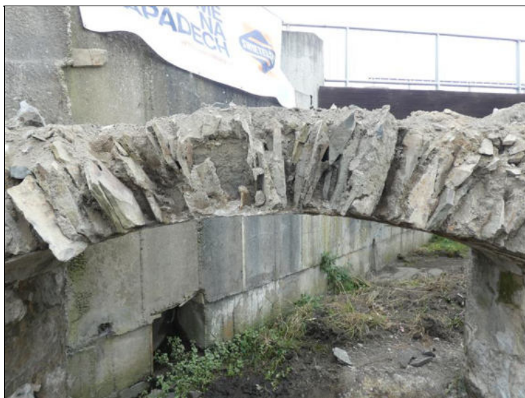
Klenební pás v 1. poli - odbouraná část zprava.
