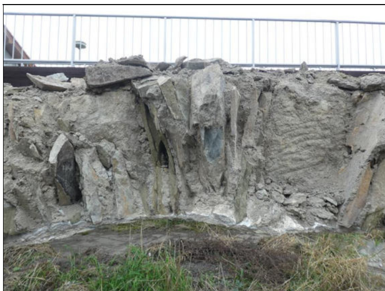
Klenební pás ve 3. poli - odbouraná část zprava.
