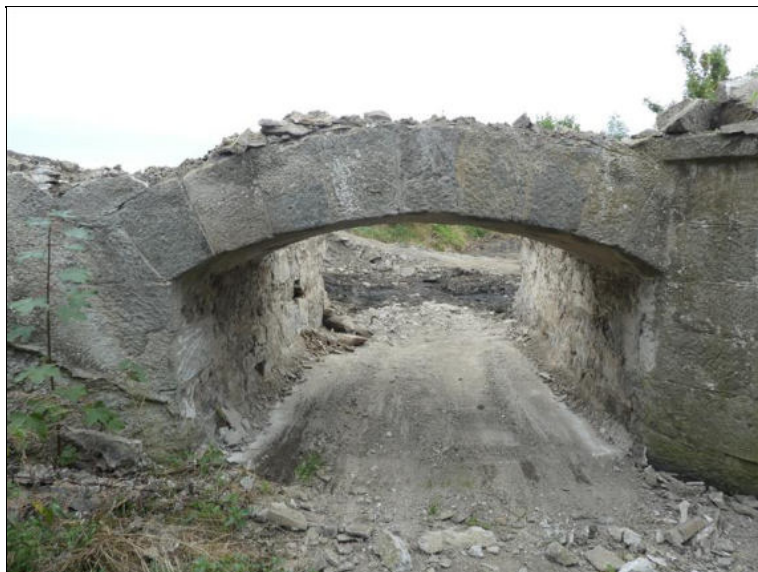
Pohled na klenební pás 4. pole
