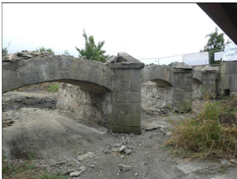
Pohled na klenební pásy 3., 2. a 1. pole zleva.
