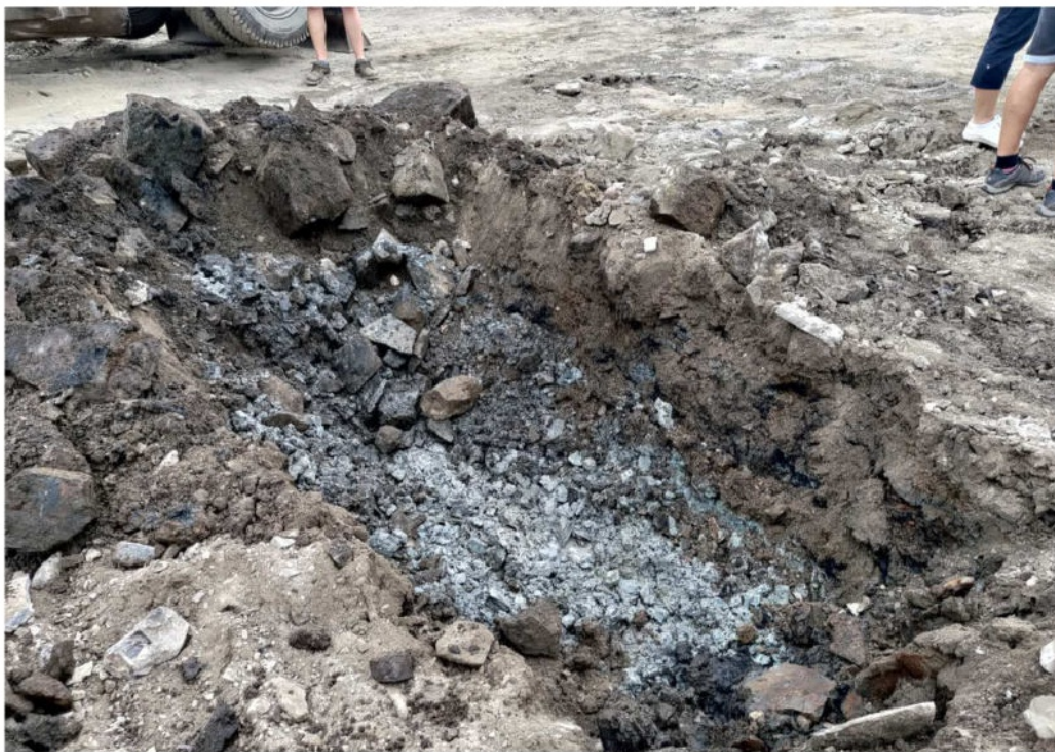
Obr. 5 – vlevo nahoře vykopané volně uložené kameny bez pojiva, v jámě potom povrch rostlého terénu
