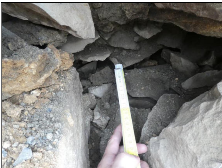
Pohled do sondy na OP5.
