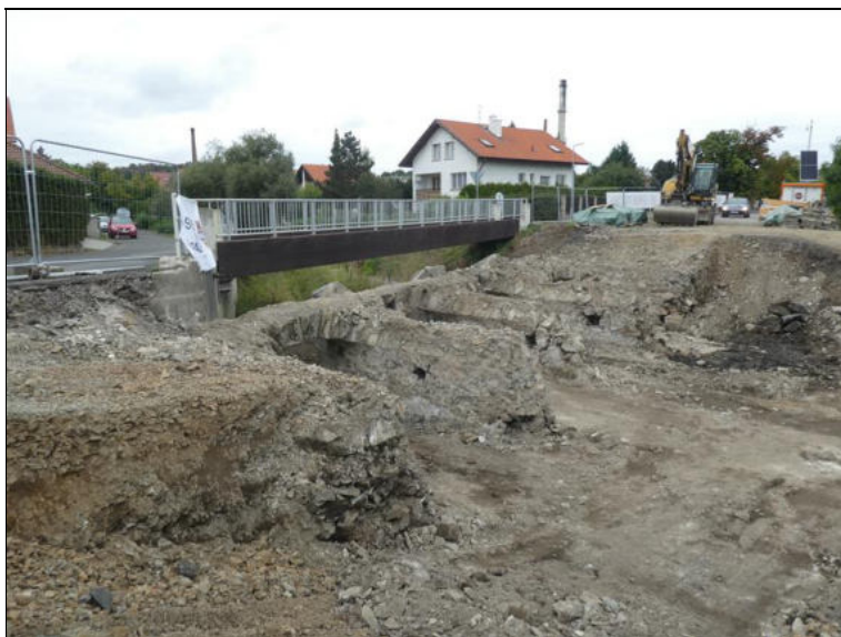
Pohled na most ve směru staničení.
