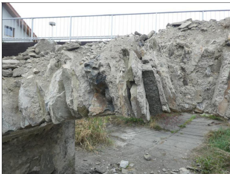
Klenební pás ve 4. poli - odbouraná část zprava.
