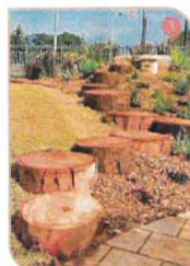
Stupně z dřevěné kulatiny
