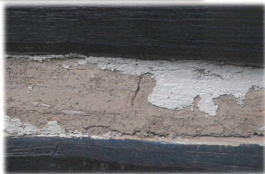
obr. 10 a 11: Detailní pohled na skladbu spárování. Hlinito-jílová vymazávka s řezankou přetřena vápenným nátěrem.
