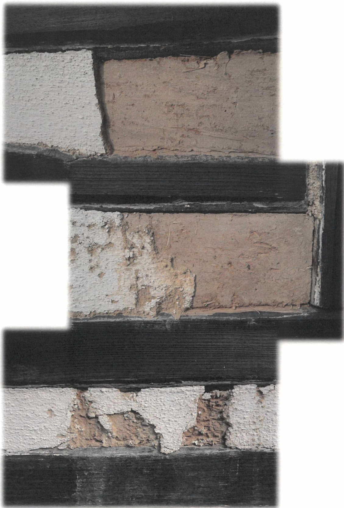
obr. 7-9: Detailní pohled na skladbu spárování. Hlinito-jílová vymazávka s řezankou, vrstvičkou štukey a vápenným nátěrem.
