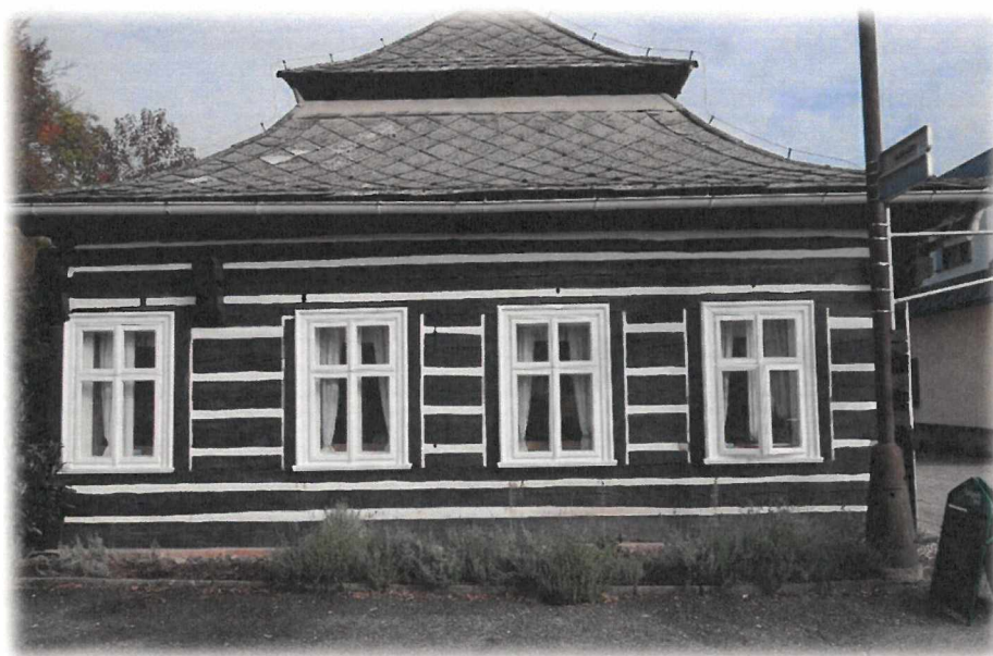
obr. 2: Celkový pohled na Gernatův dům od jihu.
