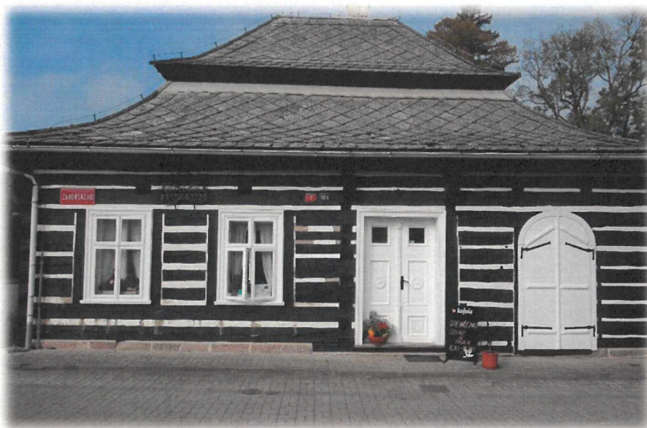
obr. 1: Celkový pohled na Gernatův dům od východu.
