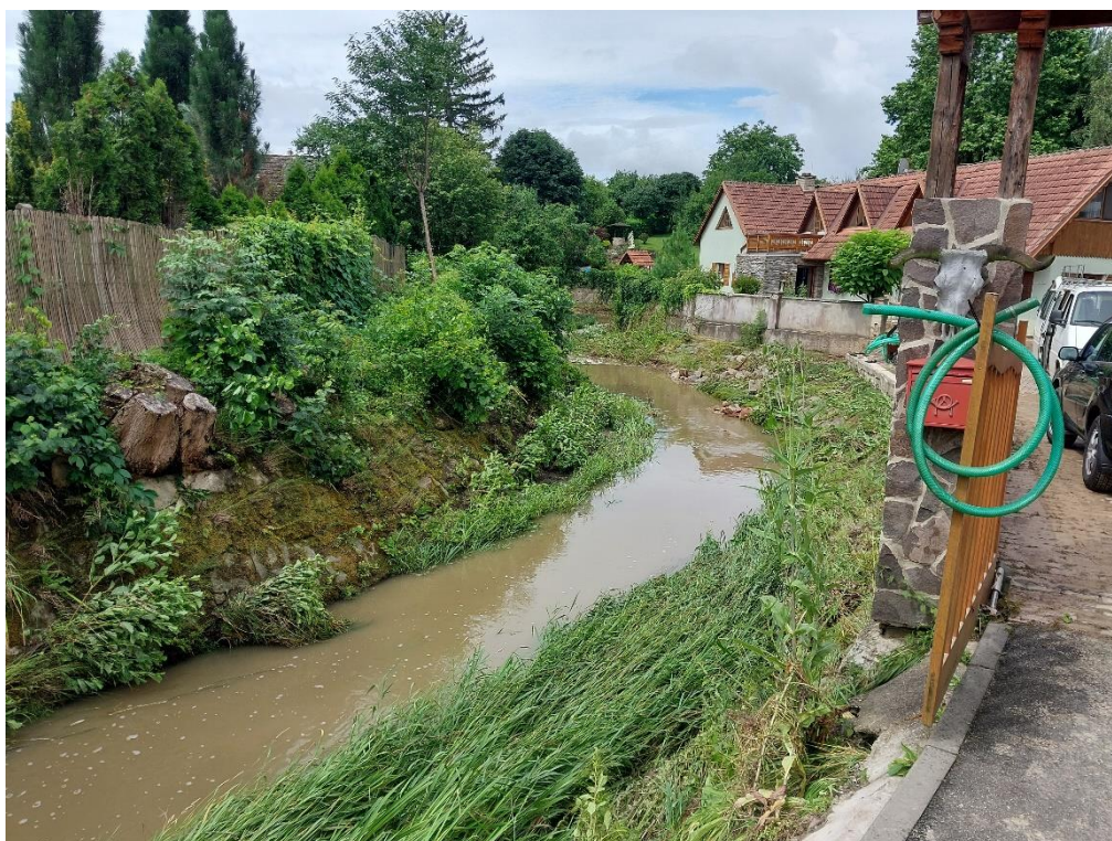
Obr 2 Pohled po proudu. Soutok s pravostranným přítokem v ř.km 0,950. Úsek v ř.km 0,820-0,970 nepřístupné koryto, nutné přehazování.
