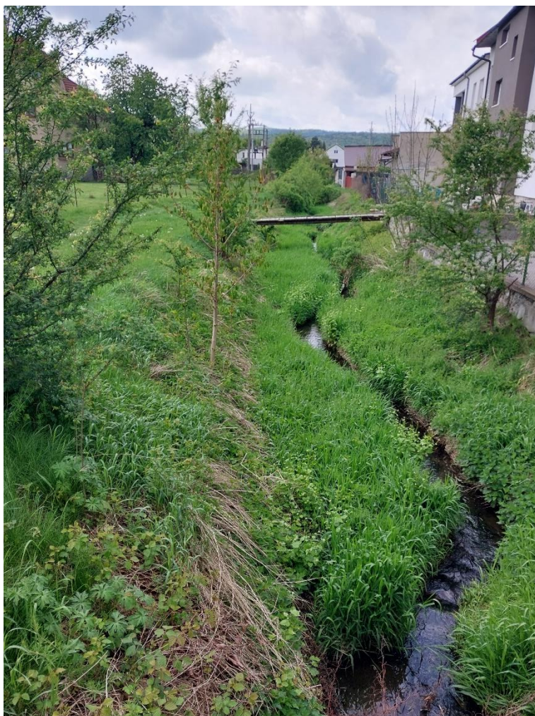
Obr 4. Pohled po proudu z mostku v ř.km 1,3. Koryto přístupné z levého břehu, za předpokladu užití lehké mechanizace.
