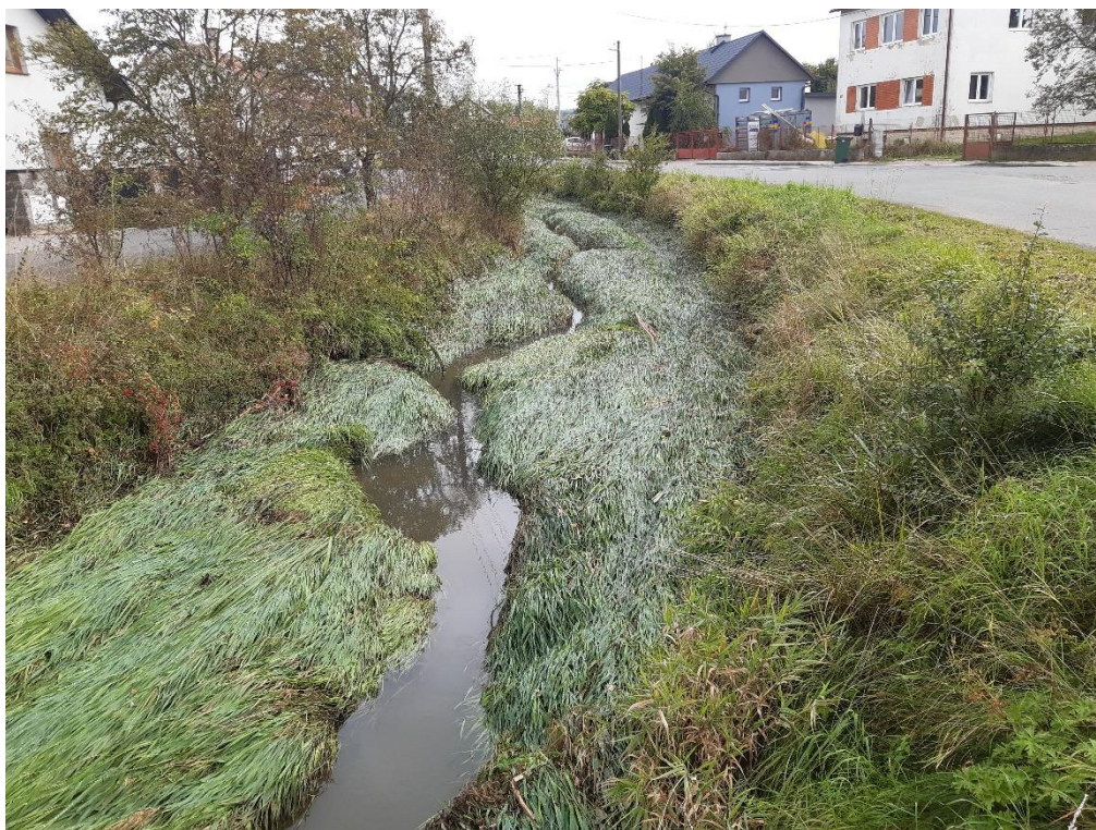
Obr 3 ř.km 1,000 pohled proti proudu. Koryto je přístupné po ř.km 1,15 z místní komunikace.
