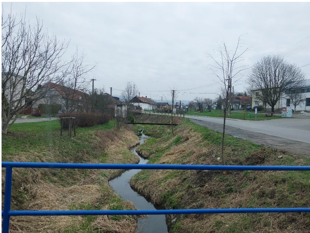
Obr 1 ř.km 0,7 pohled proti proudu. Od 0,0 možno provádět práce z místní komunikace, koryto je přístupné.
