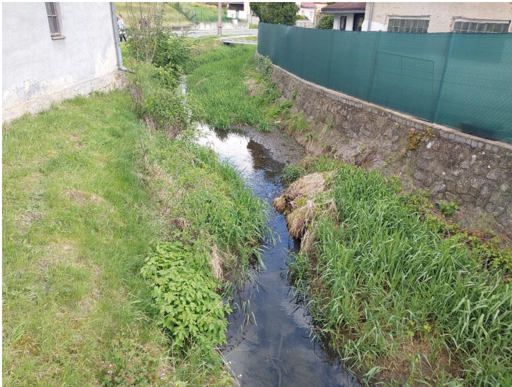
Obr 5 Pohled proti proudu v ř.km 1,63. Úsek v 1,4-1,6 je částečně nepřístupný – přehazování korytem. Dále po ř.km 1,7 souběh se silnicí II třídy. Nutné zvláštní užívání komunikace.
