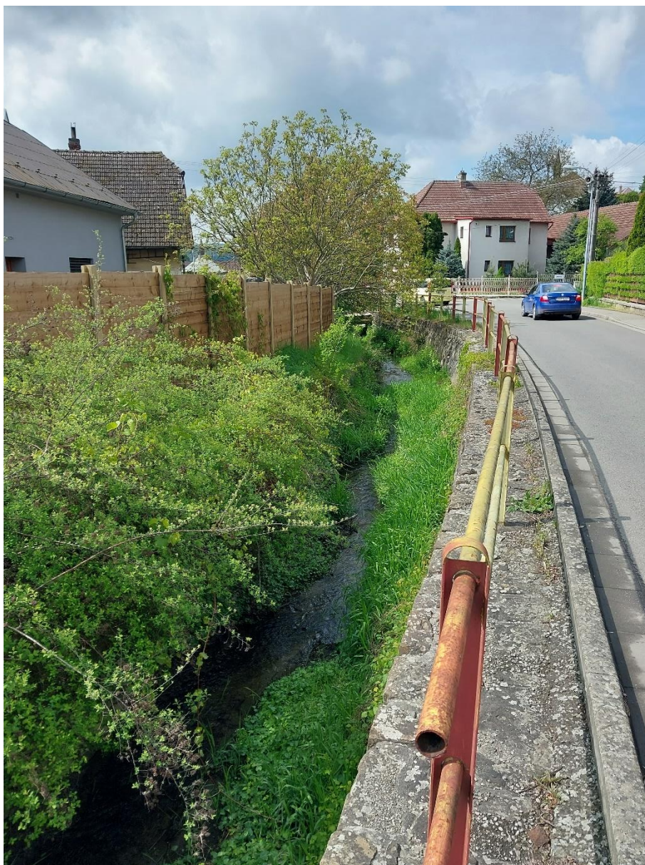
Obr 6 pohled po proudu ř.km 1,85. Od 1,8 po 2,05 vede koryto v souběhu s místní komunikací. Pro provádění bude nutné zajistit objízdou trasu. Mezi ř.km 2,05 a 2,1 je koryto sevřené v oboustranných OZ.
