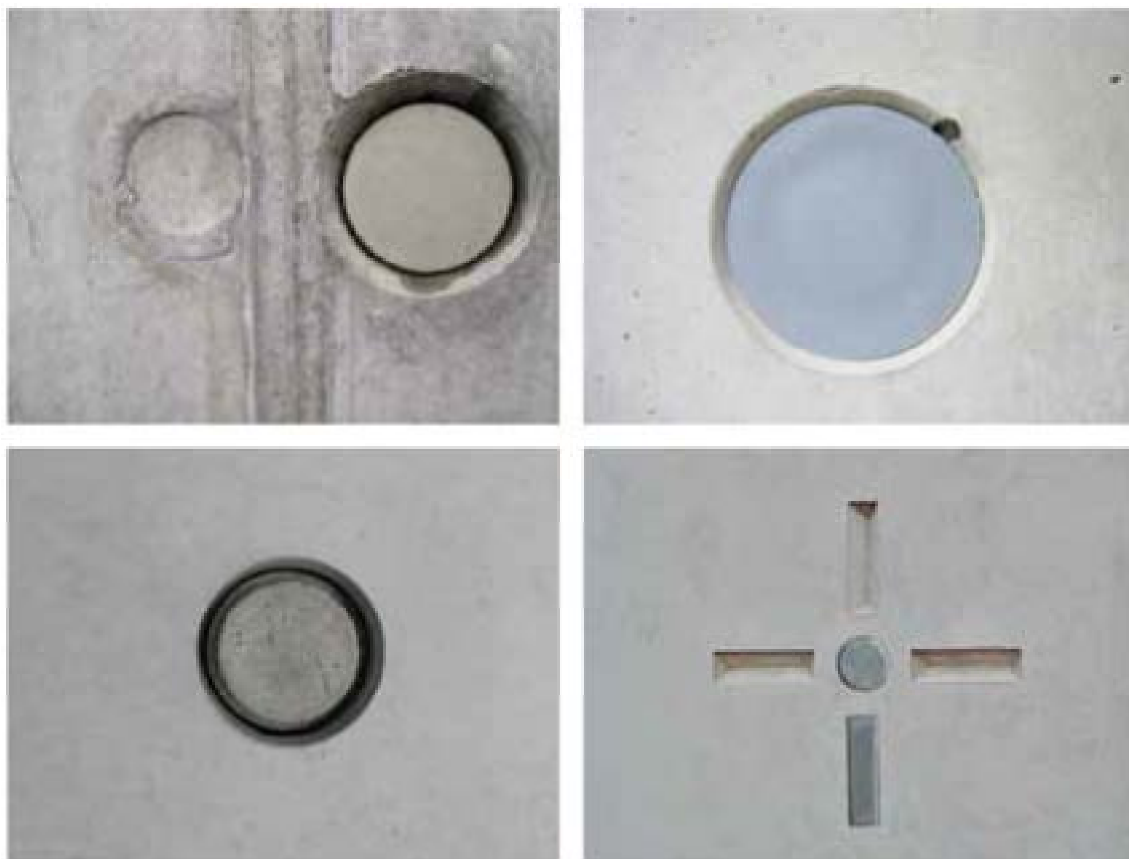
(23) Obr. F.2 – Různé způsoby uzavření spínacích otvorů
