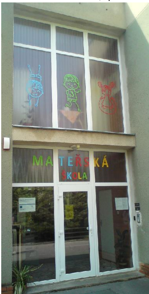
Venkovní pohled na již realizované stěny
