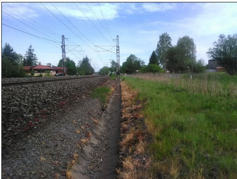
Obrázek 6 Pohled na zemní těleso a příkop podél koleje č. 2 (vpravo ve směru staničení) v km 303,400 s vlhkomilnou vegetací vpravo. Stav 3.5.2024.
