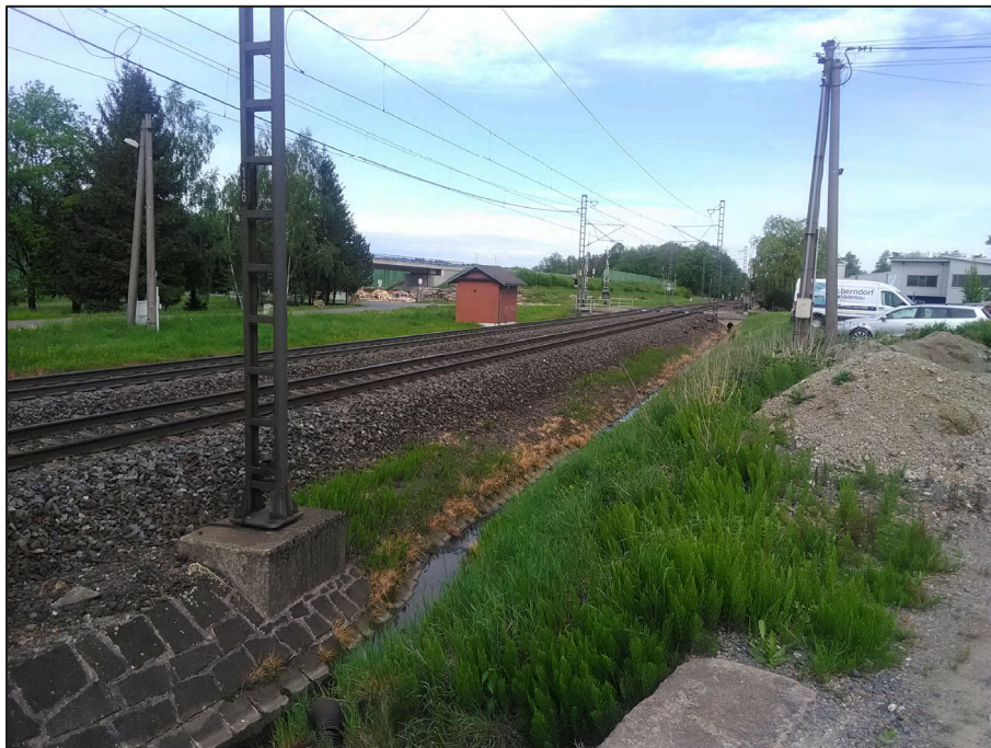
Obrázek 7 Pohled na odvodnění podél koleje č. 2 pod vyústěním vodoteče do příkopu v km 303,500. Stav 3.5.2024.
