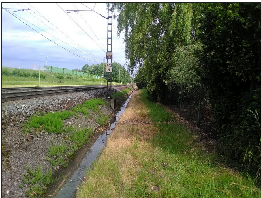
Obrázek 8 Pohled na odvodnění podél koleje č. 2 v km 303,600 vpravo ve směru staničení, za přejezdem. Stav 24.5.2024.
