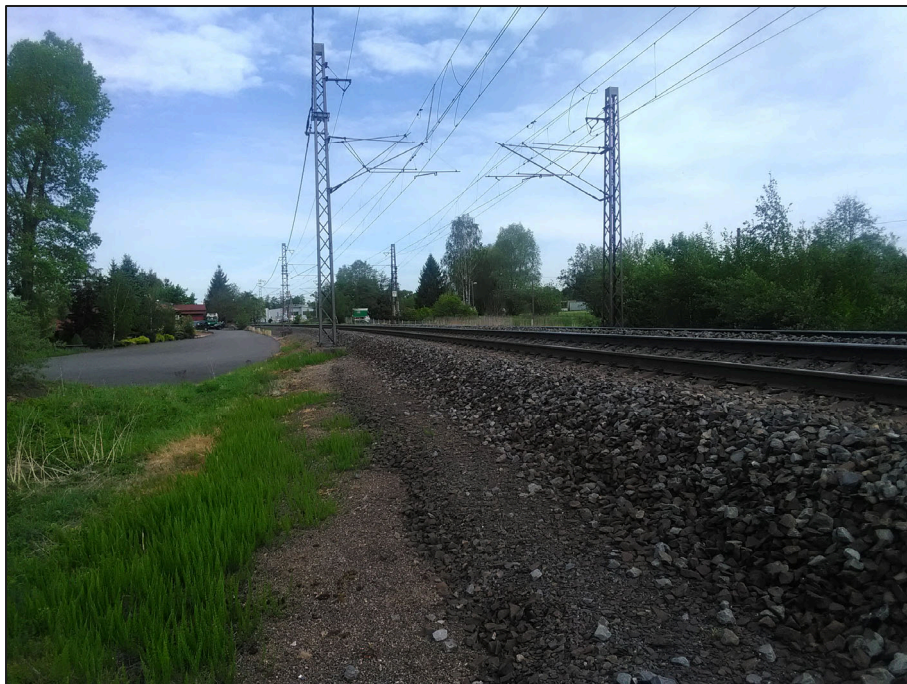
Obrázek 6 Pohled na zemní těleso a příkop podél koleje č. 2 (vpravo ve směru staničení) v km 303,400 s vlhkomilnou vegetací vpravo. Stav 3.5.2024.
