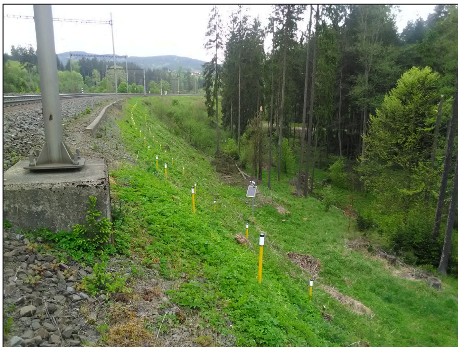
Obrázek 4 Pohled na podélné štěrkové žebro u paty svahu násypu u koleje č. 1 (pohled od km cca 286,900 ve směru staničení). Stav 3.5.2024.
