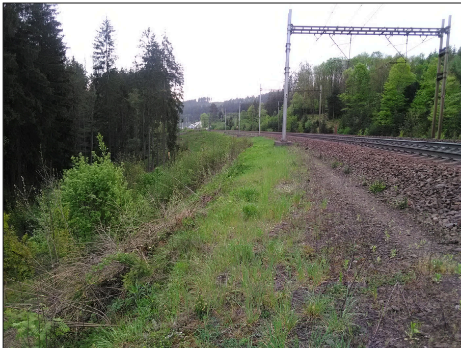
Obrázek 5 Pohled na svah násypu pod kolejí č. 2 (pohled od mostu v km 287,019) proti směru staničení. Stav 3.5.2024.
