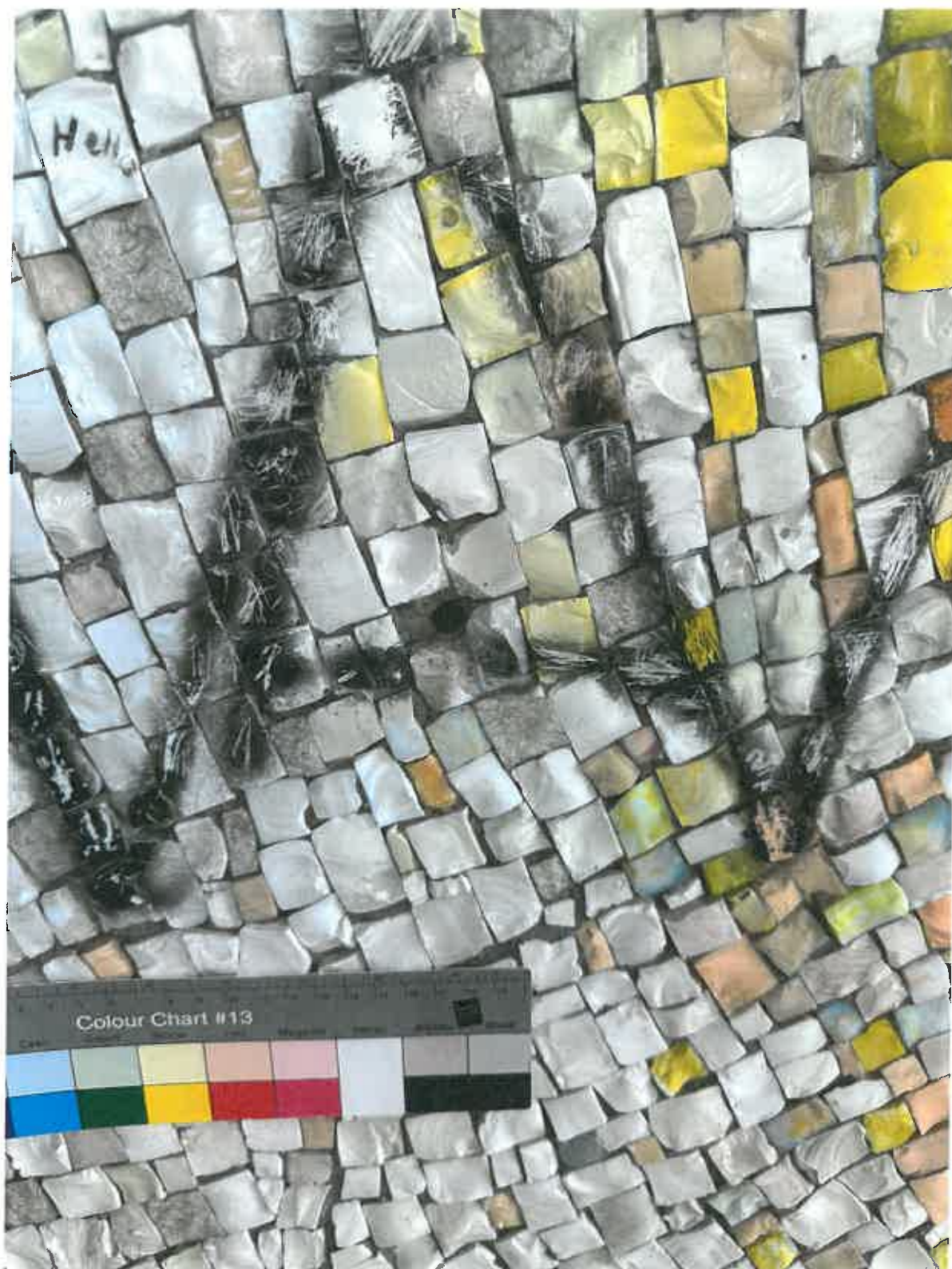
Detail: znečištěný povrch mozaiky, graffiti, nápisy
