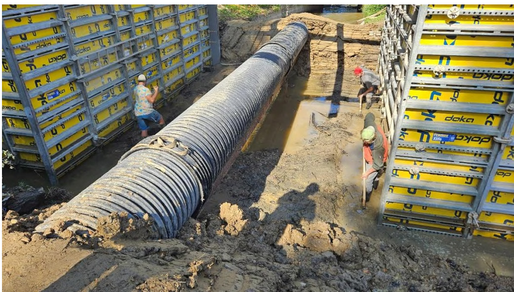
Vyklížení naplavenin ze základové desky.
