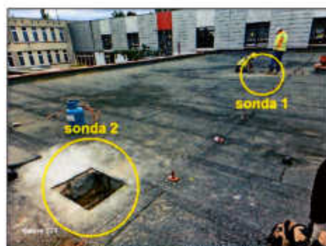
Obr. č. 6 Pohled na Sondy 1 a Sondy 2
