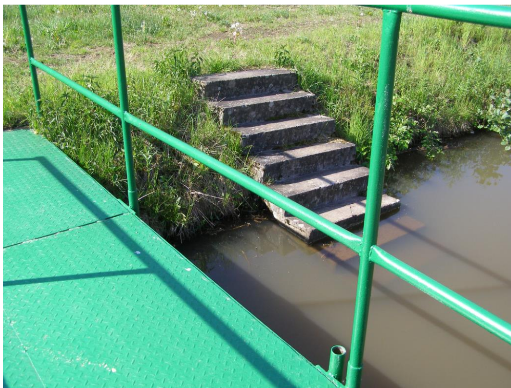
Schodiště vedle vypouštěcího a odběrného objektu
