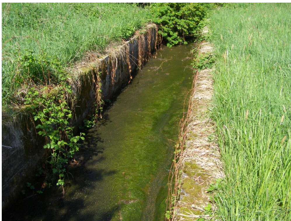
Otevřená část odpadu od bezpečnostního přelivu
