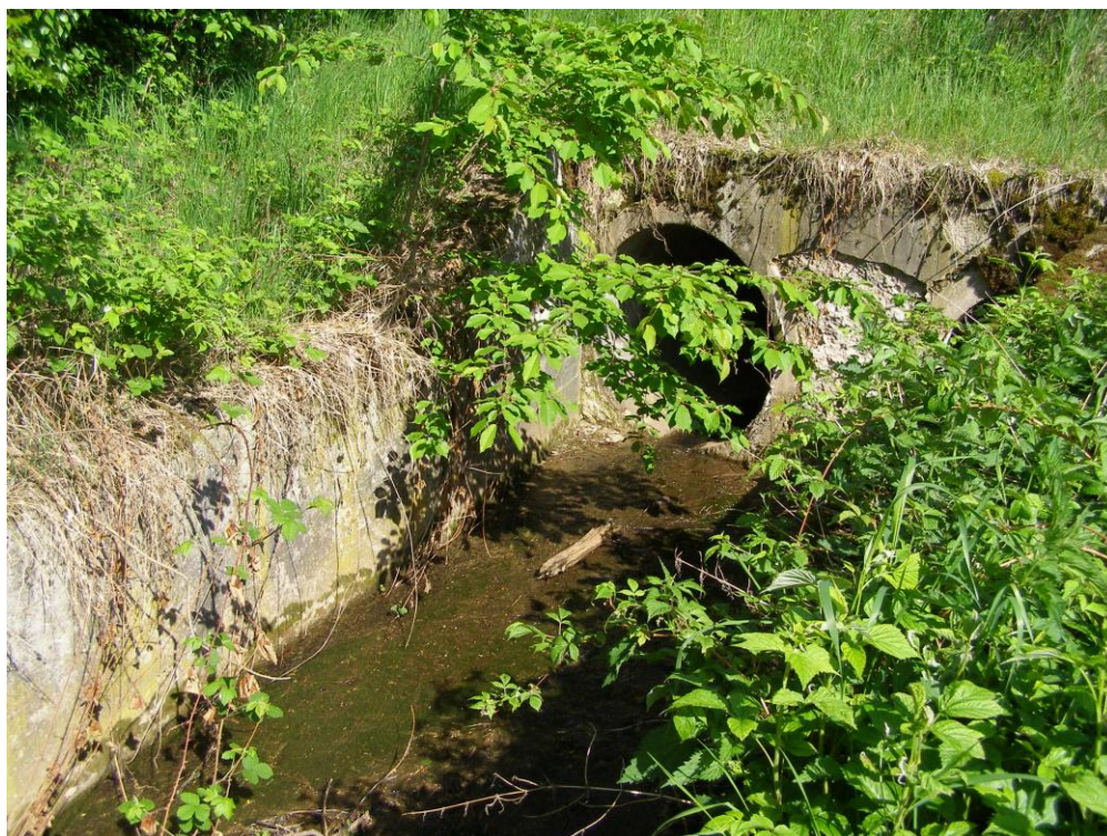
Výtok ze zatrubněné části odpadu od bezpečnostního přelivu
