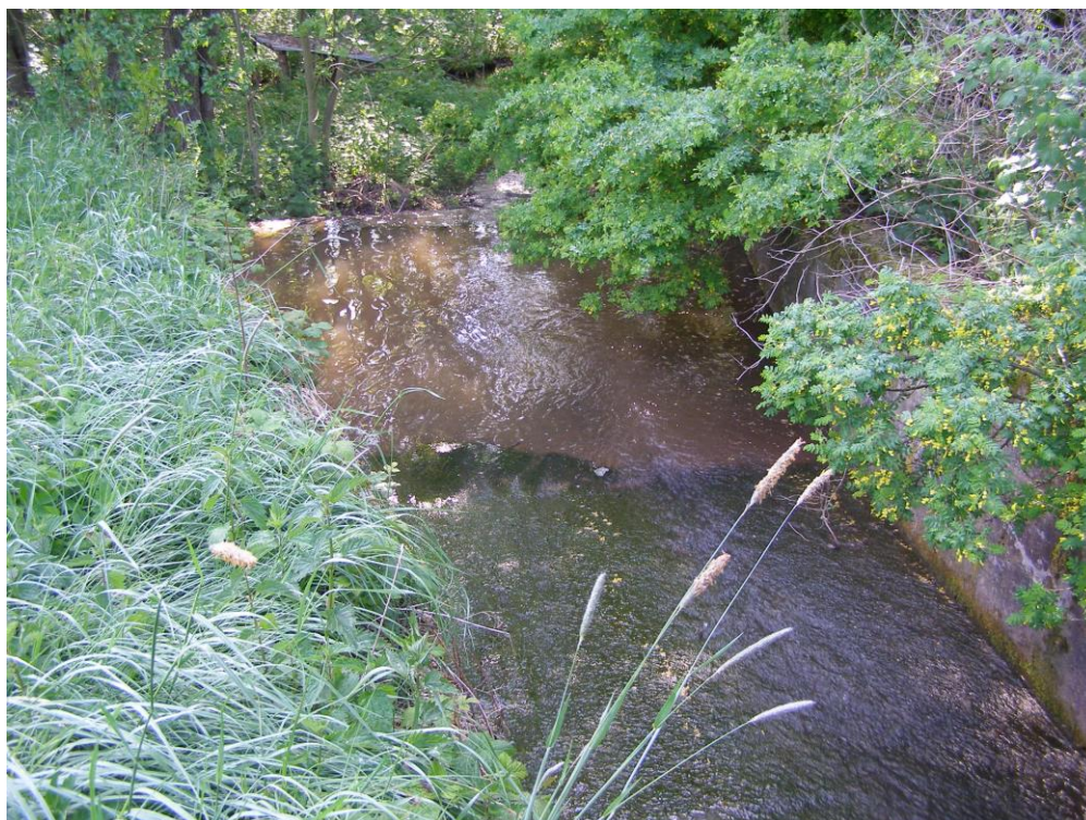
Konec odpadu od bezpečnostního přelivu a začátek vzdutí dolní nádrže
