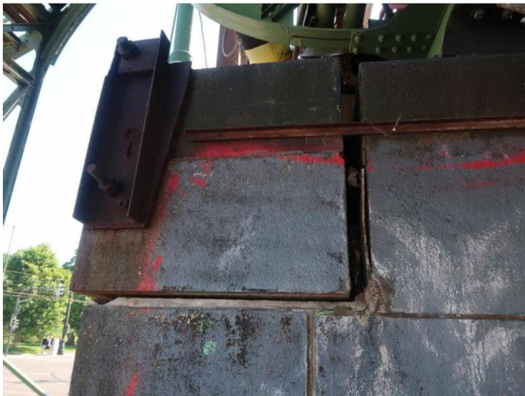
Opěra O 01 úložný práh:
