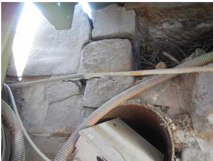
Opěra O 02 závěrná zeď: – vpravo – uvolněné 2 kameny
