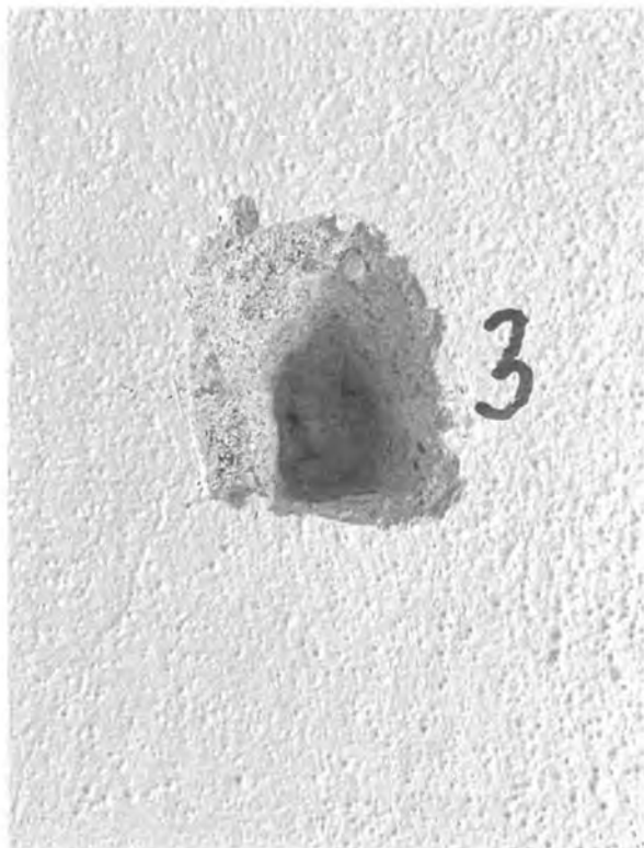
Místnost 211 – sonda na stropě – bez nálezu, rákosové podbití
