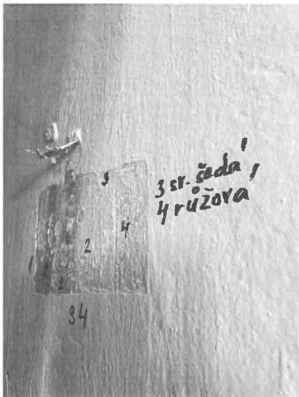
Místnost č. 219a – stěna za kachlovými kamny
