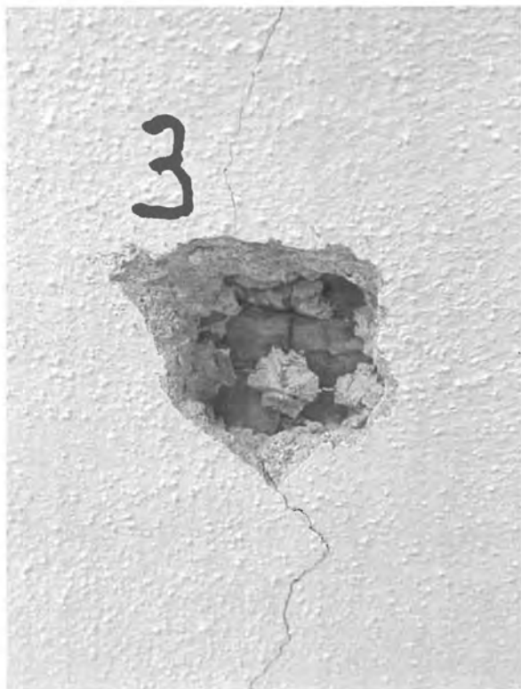
Místnost 211 – sonda na stropě – bez nálezu, rákosové podbití
