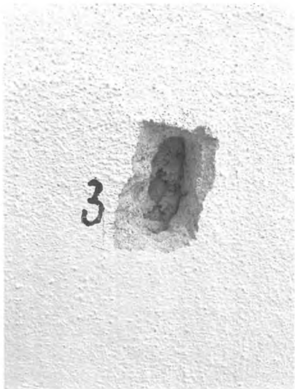
Místnost 214 – sonda na stropě – bez nálezu, rákosové podbití
