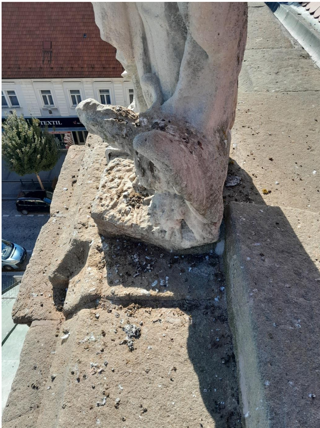
5) socha sv. Jana – znečištění ptačím trusem.
