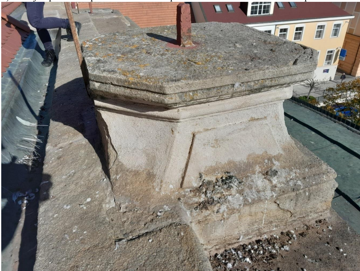
7) Stávající podstavec pod sochou Krista Spasitele bude nahrazen tesanou kopií.
