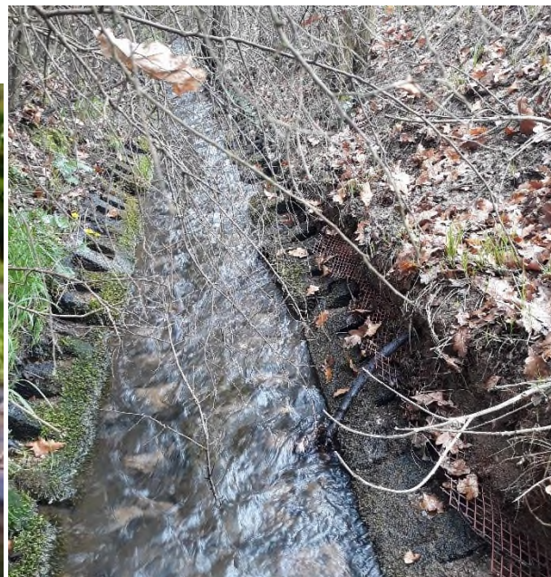
Obr. 26: Kamenná dlažba do betonu (vlevo), vegetační tvárnice (vpravo), v obou případech se jedná o stabilní profil bez známek břehové eroze (vliv úprav koryta a jejich udržování) – viz parametr 5
