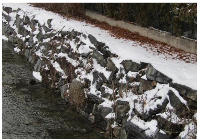
Obr. 25: Kamenná rovnánina (vlevo), zpřírodněná kamenná rovnánina (vpravo)
