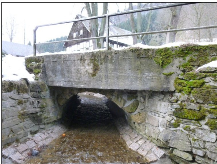
Pohled na most zprava, proti proudu
