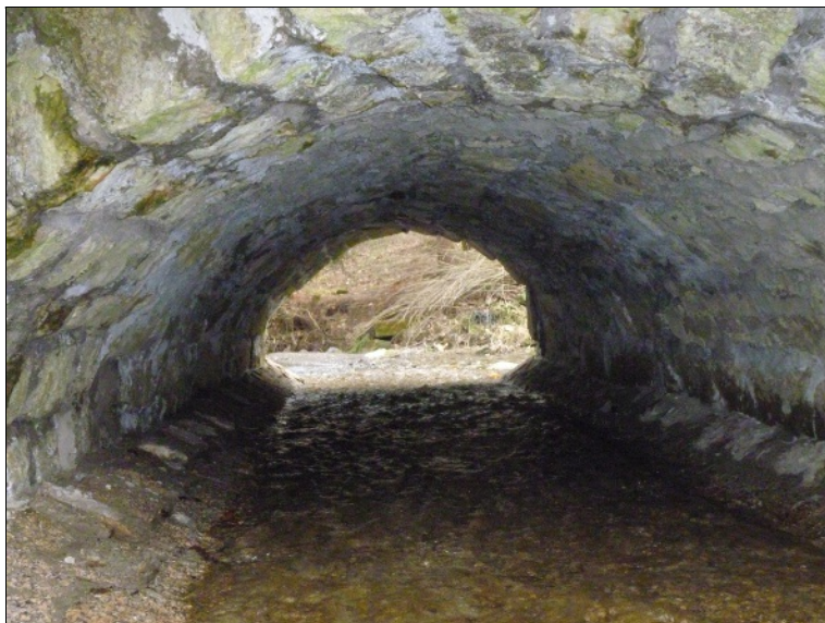
Pohled do mostního otvoru zleva, po proudu
