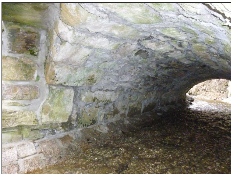
Pohled na opěru I zprava, proti proudu
