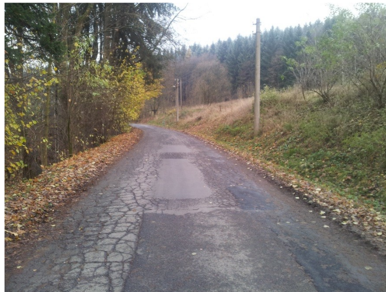
Silnice II/592 Kryštofovo údolí – Křižany, rekonstrukce silnice
