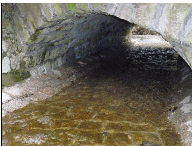
Nové opevnění dna vodoteče pod mostem
