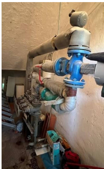
Obr. Regulační uzle pavilonu A, B, C
