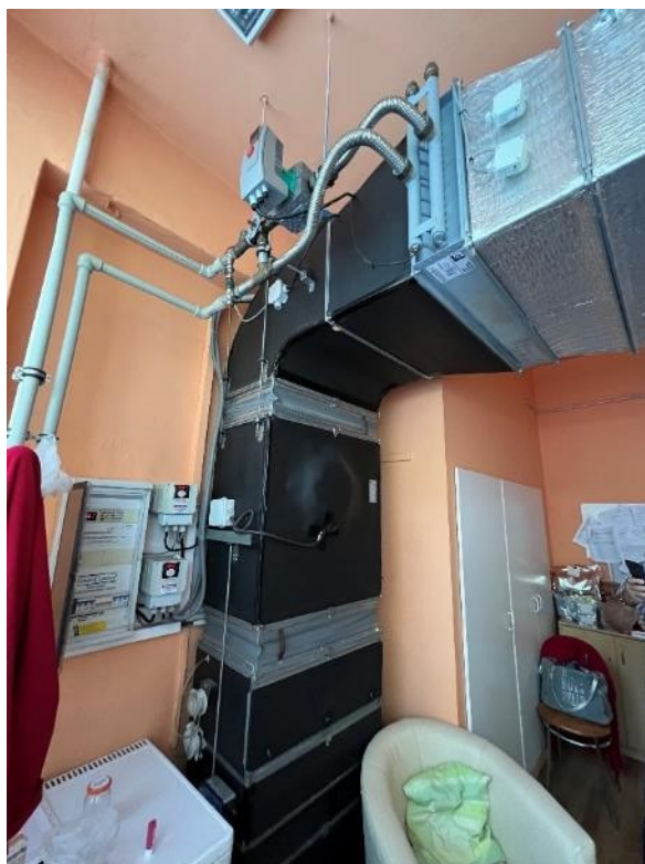
Obr. Regulační uzel pro výměník VZT
