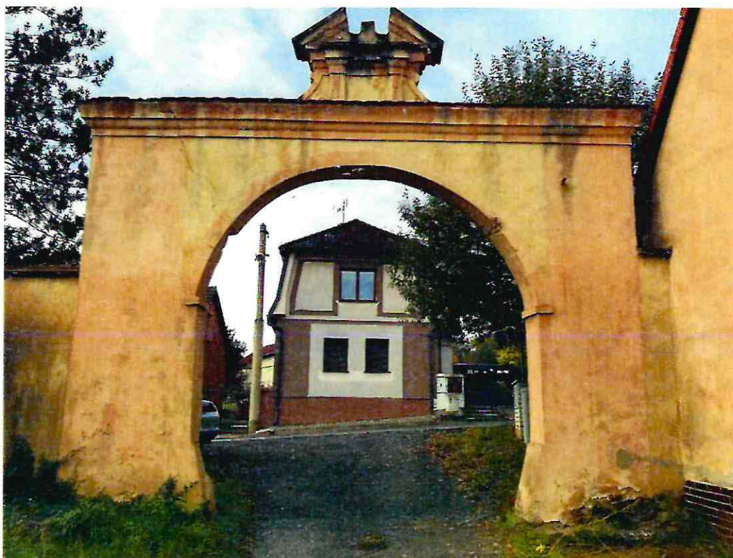
Foto č. 04 – Celkový pohled na bránu č.1 směrem od východu
