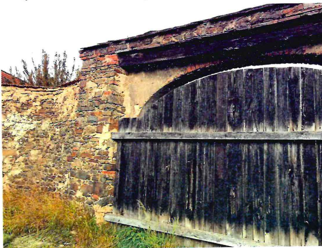
Foto č. 11 – pohled levou část a dřevěný trám na jižní straně brány č.2
