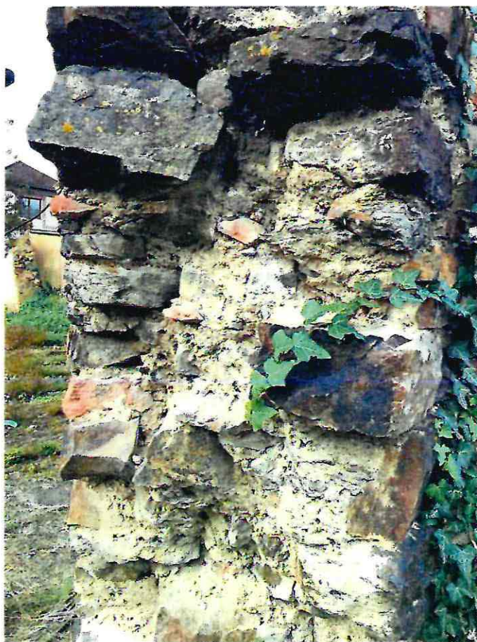
Foto č.10 – Detail provedení sendvičového zdiva brány č.2
