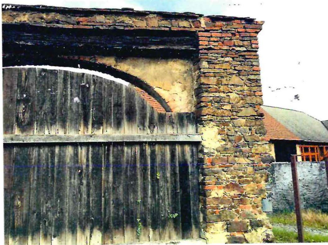
Foto č. 12 – Pohled na pravou část jižní stěny brány č.2 s dřevěným trámem
