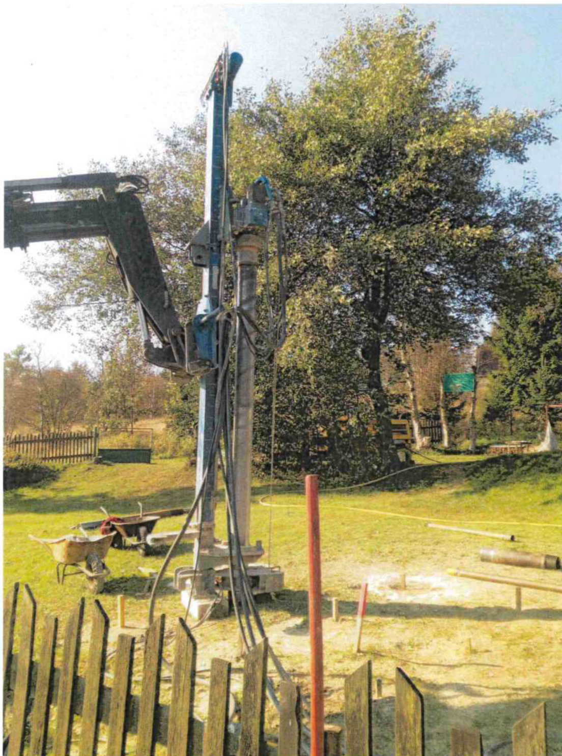
Foto č. 3 Průzkumné práce SDD jámy Urselschacht vrtnými sondami
