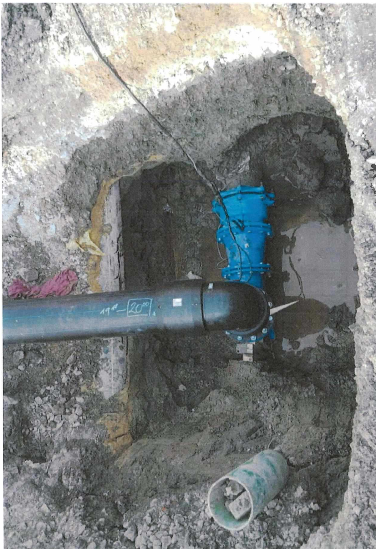
SO 302_SU – Suchovod – napojení KÚ
