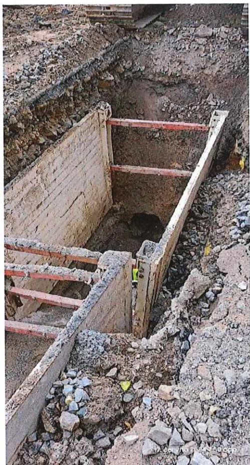
SO 301_OP_v – Ochrana plynovodu – sesypaný obsyp plynovodu
