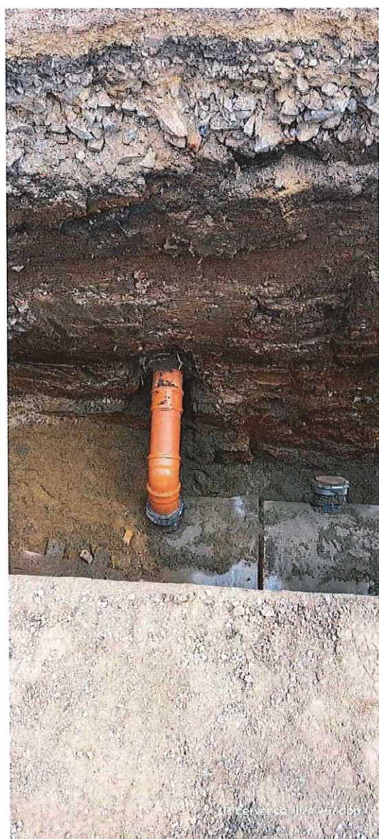
SO 301_PKU_v – Kanalizační přípojka km 0,140 (UNIPACK) – realizovaná přípojka
