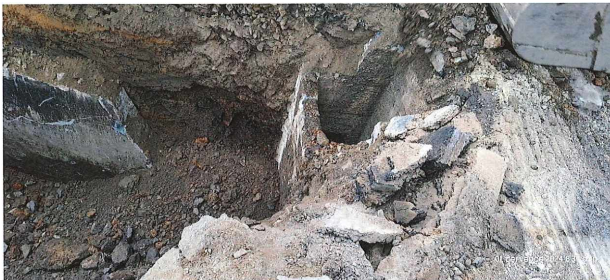
SO 301_ÚSK_v – Úpravy na stávající kanalizaci – bourání stávajících kanalizačních šachet
