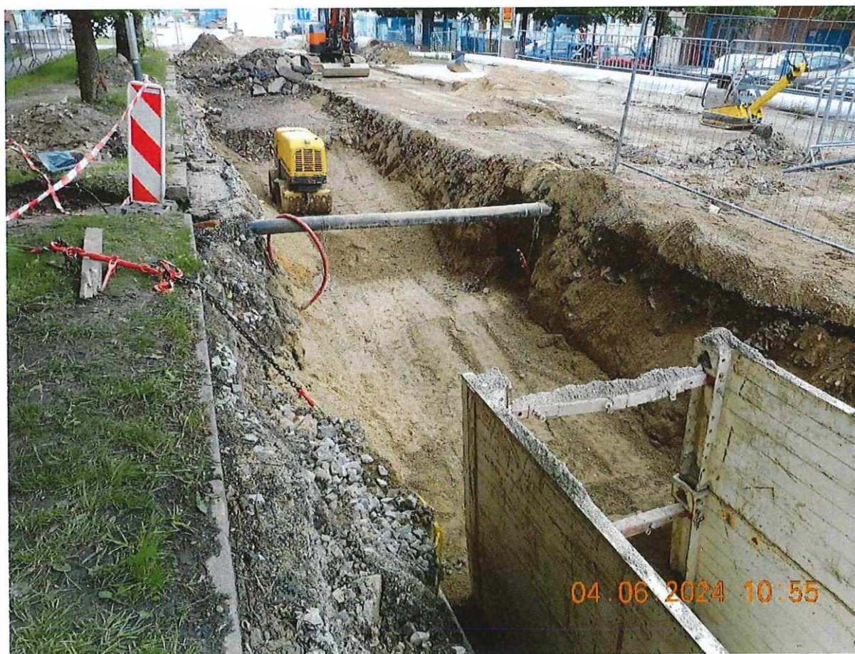
SO 301_OP_v – Ochrana plynovodu – zajištění + zpětný obsyp
