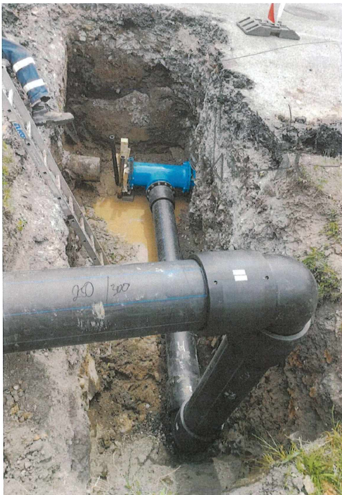
SO 302_SU – Suchovod – napojení ZÚ
