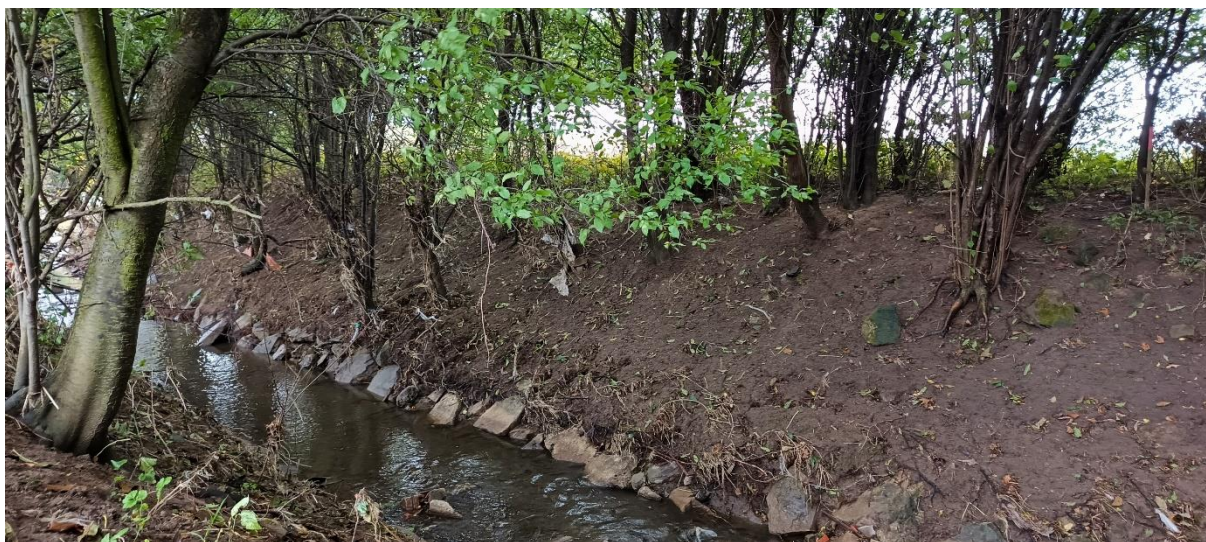
Obr. 3, 4: Porostní skupiny SK8 a SK9 – doporučeno odstranění porostů ve spodní části svahu, ponechání vzrostlých dřevin nad svahem, mimo koryto potoka.
