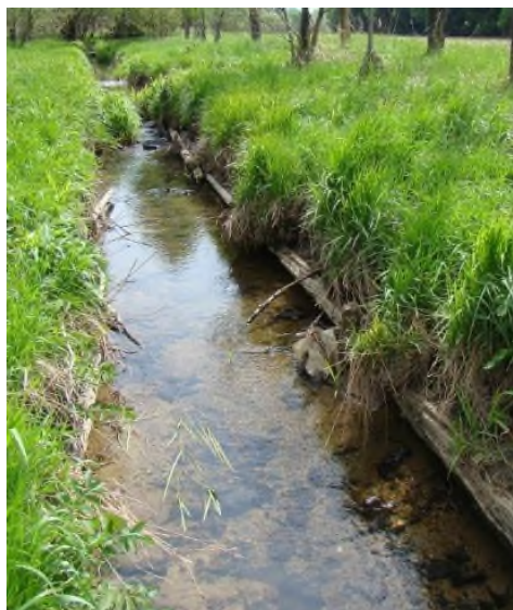
Obr. 27: Působení renaturačních procesů – rozpad a odnos opevnění břehů kulatinou (vlevo), odnos opevnění břehů kulatinou a břehové nátrže (uprostřed), obtékání opevnění (dna a paty břehů) betonovými prefabrikáty (vpravo)
