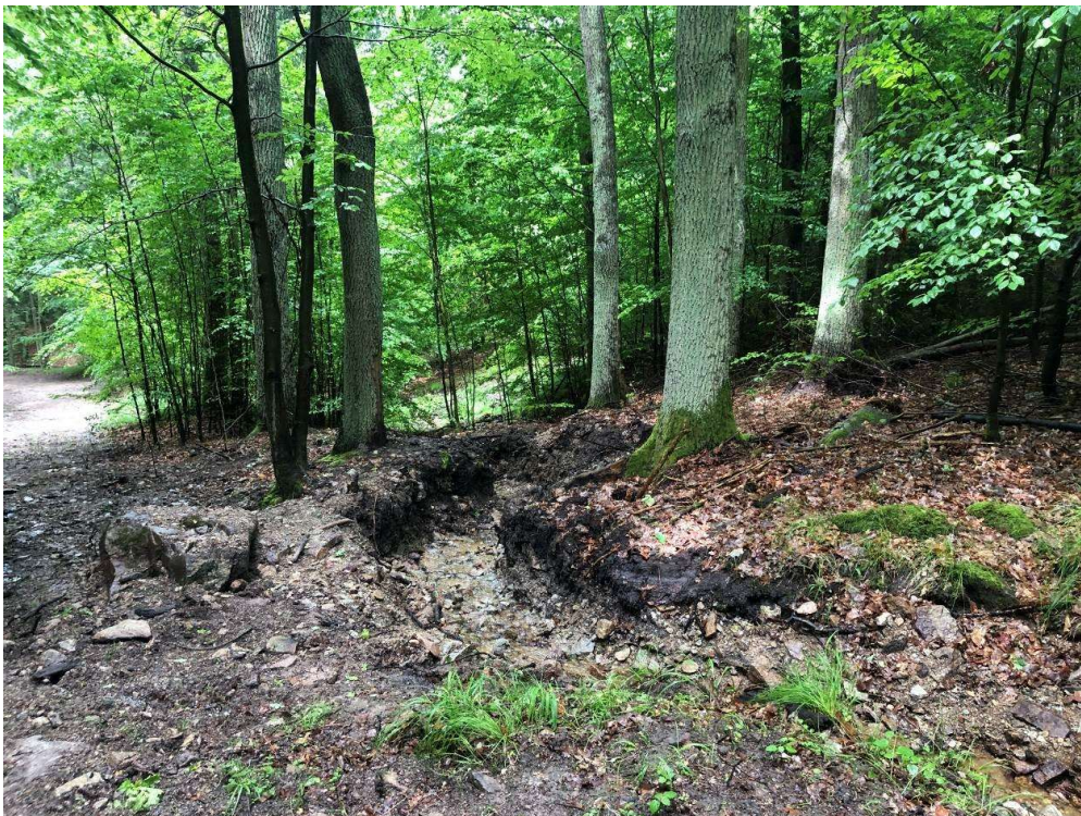
Zabezpečení koryta VT proti erozi
