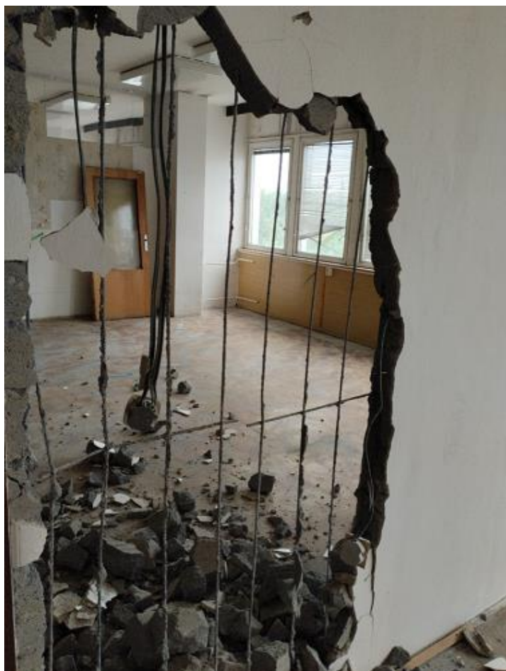
Plynosilikátové příčky vyztužené ocelovými dráty
