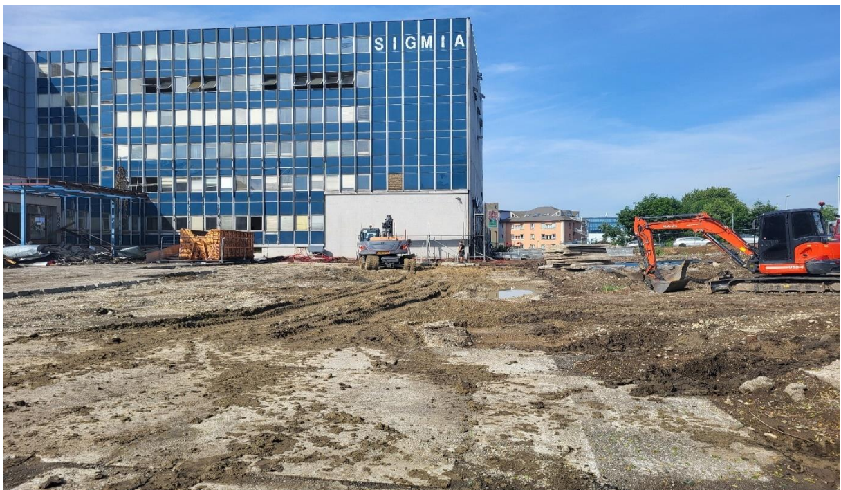
Demontáž plochy z betonových panelů
