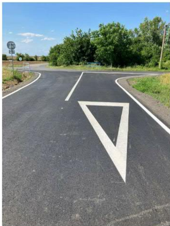
Ukončení obrusné vrstvy a VDZ
