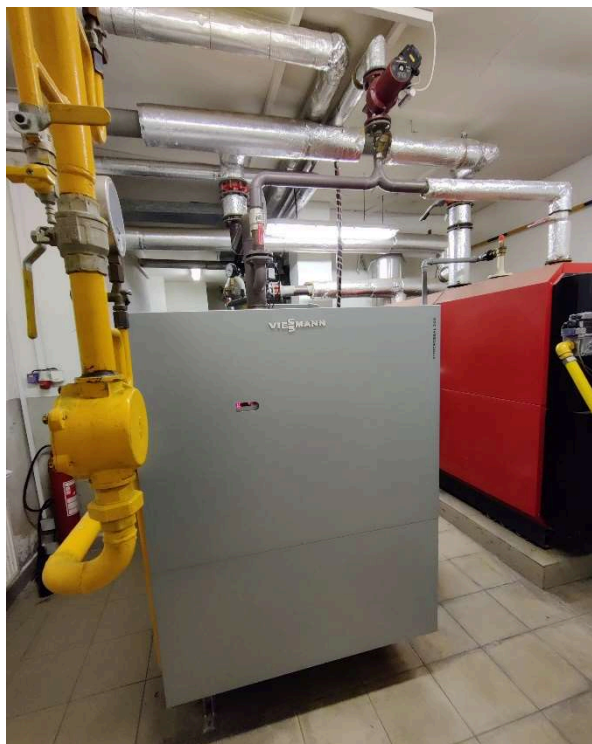
Obr. 37 Plynové kotle
