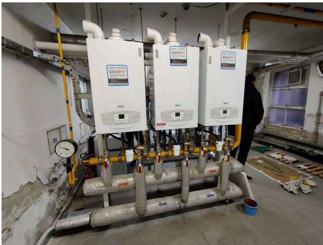
Obr. 48 Kondenzační kotle
