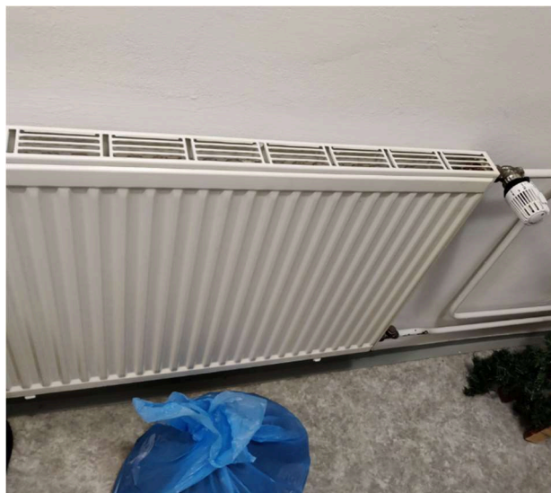
Obr. 50 Deskový radiátor s termohlavicí
