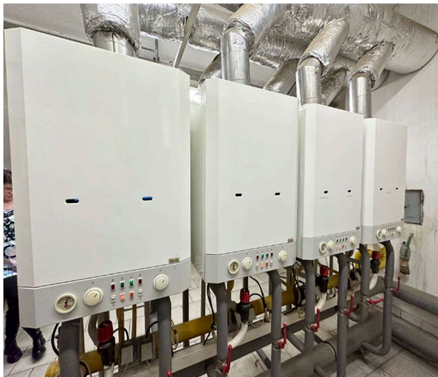
Obr. 7 Plynové kotle 1 - 4
