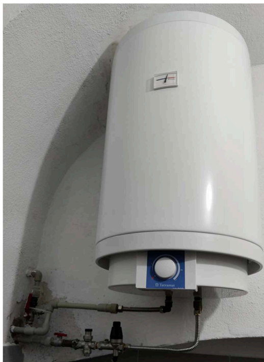
Obr. 23 Zásobníkový ohřívač
