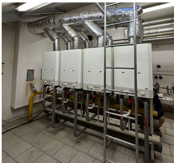
Obr. 8 Plynové kotle 5 - 8
