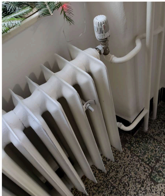
Obr. 22 Litinové otopné těleso s termohlavicí
