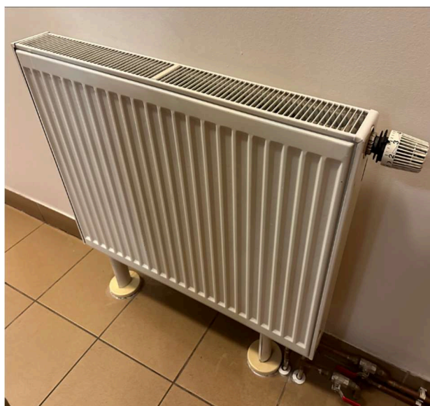
Obr. 10 Deskové otopné těleso
