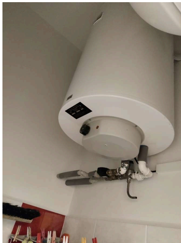
Obr. 42 Elektrický zásobníkový ohříváč
