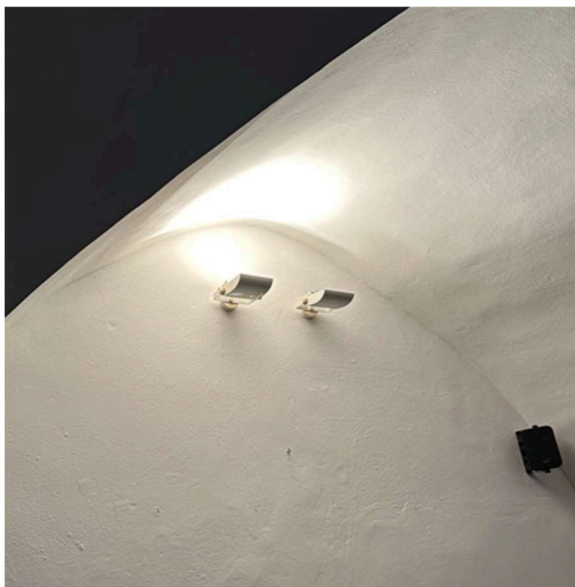
Obr. 4 Halogenová svítidla
