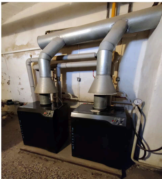
Obr. 21 Plynové kotle
