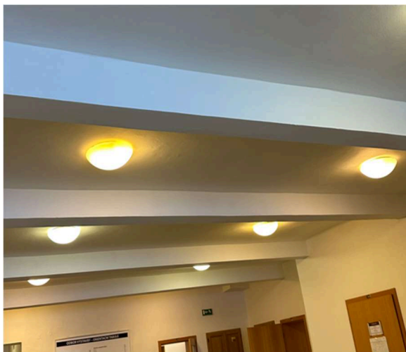
Obr. 12 Kompaktní svítidla
