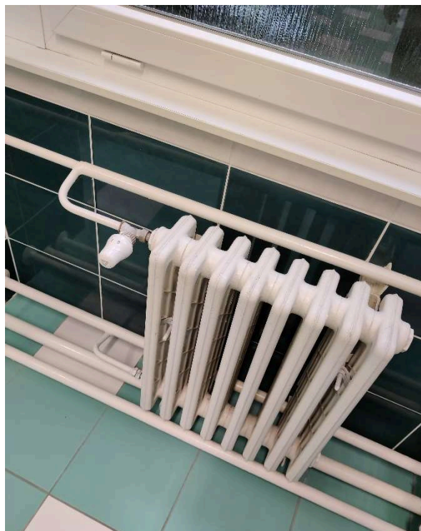
Obr. 38 Litinové otopné těleso
