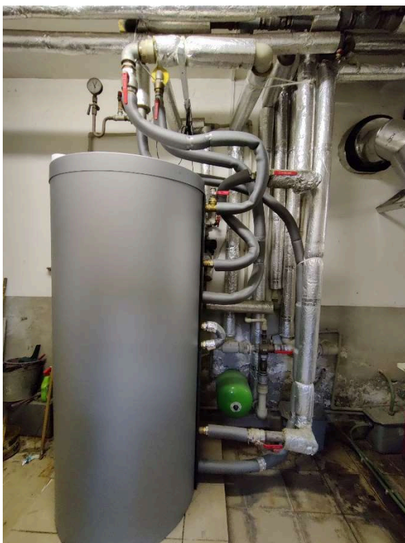
Obr. 41 Akumulační zásobník teplé vody
