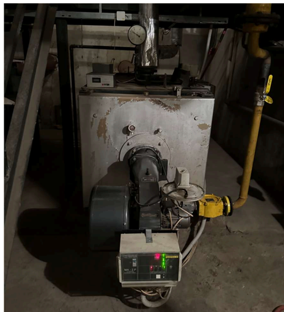
Obr. 17 Plynový kotel 2
