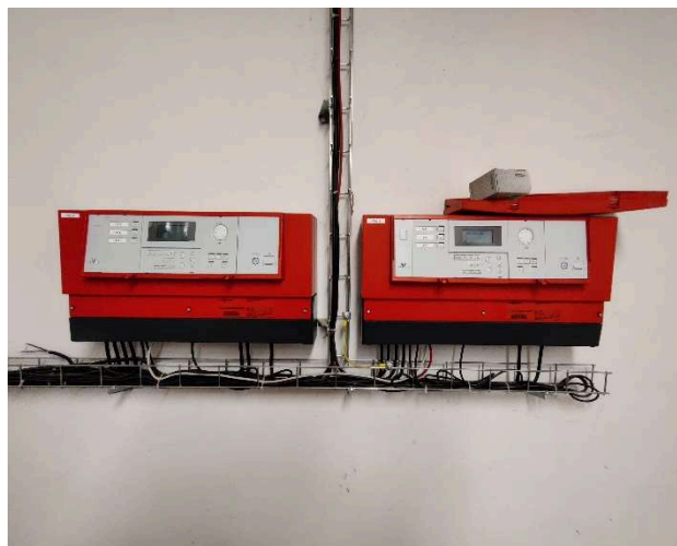
Obr. 40 Regulace kotelny
