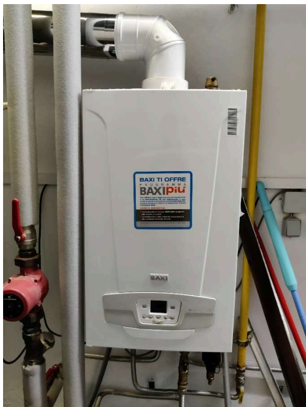
Obr. 26 Kondenzační kotel
