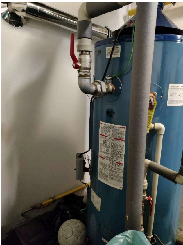
Obr. 28 Plynový zásobníkový ohřivač
