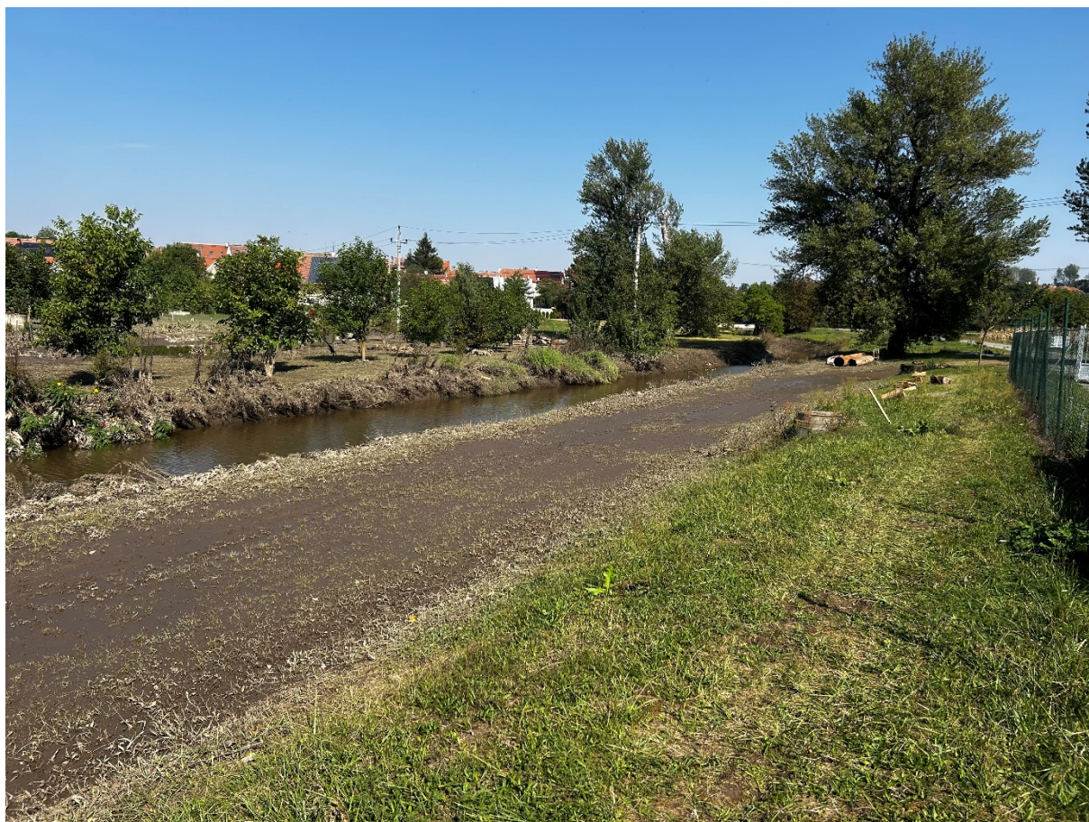
Obr. 4 – Podmáčený příjezd na stavbu
