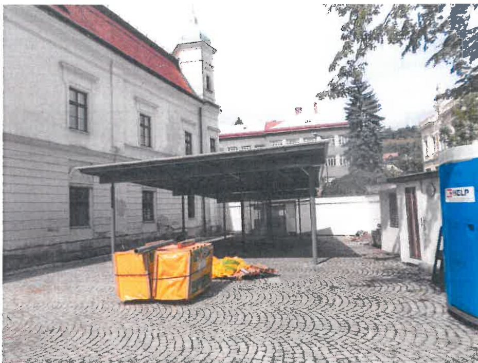
Přístřešek - celkový pohled
