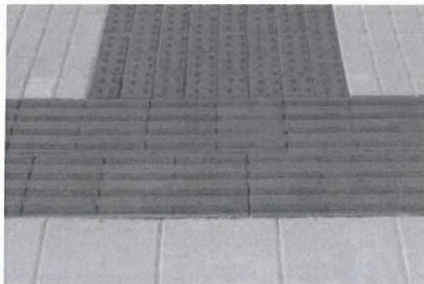
betonová hmatná dlažba B.3.3.a, B.3.3.b vodící linie, černá
