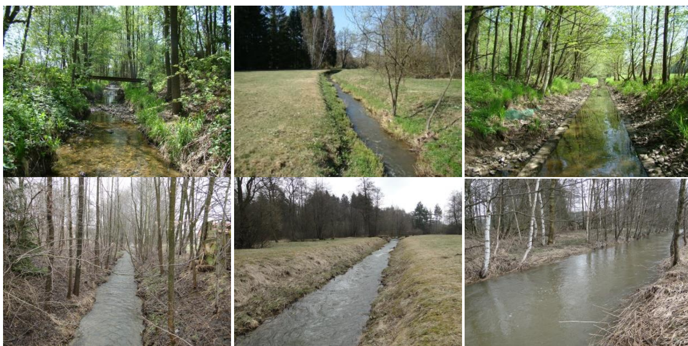
Obr. 35: Horní tok (vlevo), střední tok (uprostřed), dolní tok (vpravo) - porovnání zvýšených jarních průtoků s běžnými průtoky na drobném vodním toku pro různě kapacitní koryta. Vlevo - koryto je nadměrně zahloubené (vlivem technické úpravy, uprostřed - koryto je nadměrně zahloubené, ale přirozeným vývojem se zanáší (sesouvání břehů, akumulace šterku), vlevo - koryto je nadměrně zahloubené, ale přirozeným vývojem se zanáší (akumulace šterku splaveného z úseků výše proti proudu již téměř zaplnily úpravu koryta vegetačními tvárniciemi – vyměšlení minimálně o 30 cm oproti původní úpravě).
