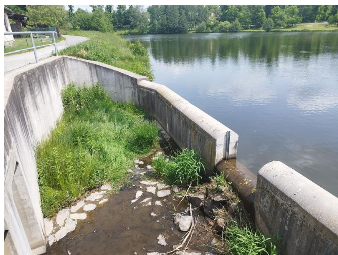
Obr. 4: Bezpečnostní přeliv průchodný pro vydru. Projektant se s požadavkem na zajištění průchodnosti pro vydru vyrovnal tak, že úplně zrušil svislou stěnu pod hranou přelivu a navrhl z čela kašny pozvolný skluz (vlevo). Vpravo - vyrovnaná hromada kamenů v místě pod oknem přelivu činí přeliv obousměrně průchozí. Pokud je průchozí i navazující most pod silnicí, zvířata mohou bezpečně migrovat podél toku, aniž by musela přecházet silnici.
