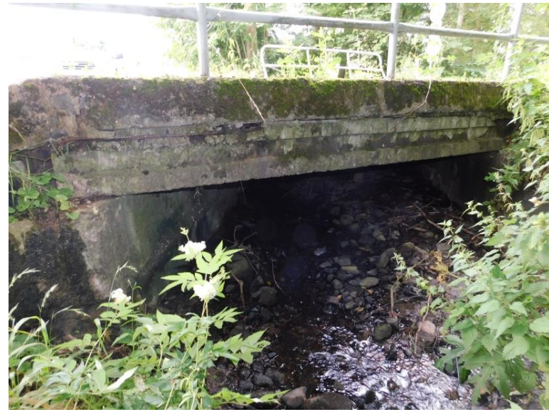
Most ev. č. 24091-2 Velká Javorská
