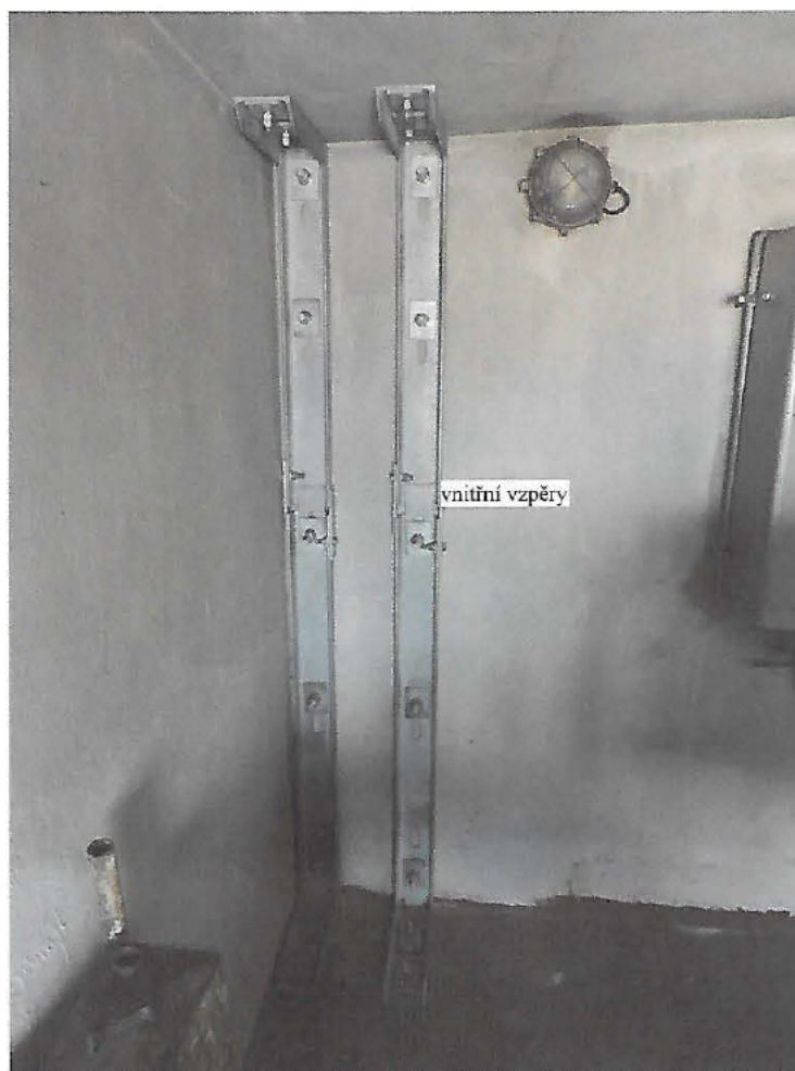
Obr. č.3, Vnitřní vzpěry příhradového stožáru SP400 – východ
