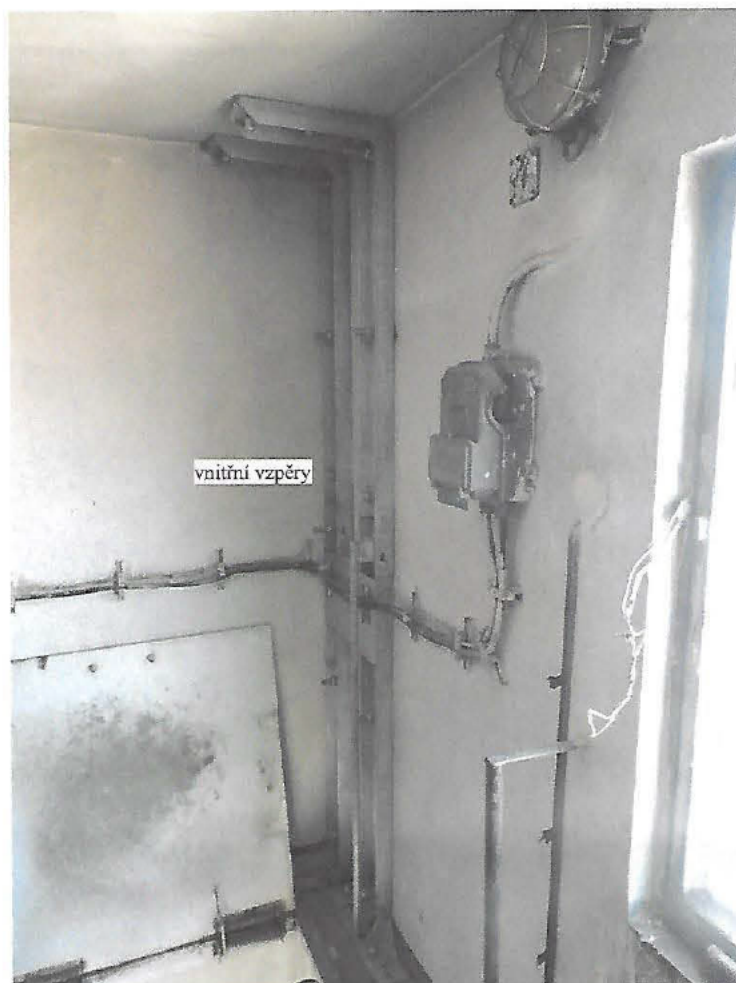
Obr. č.3, Vnitřní vzpěry příhradového stožáru SP400 – západ
