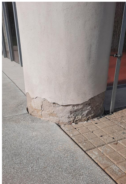
Obr.: Detail levého rohového sloupu; východní strana
