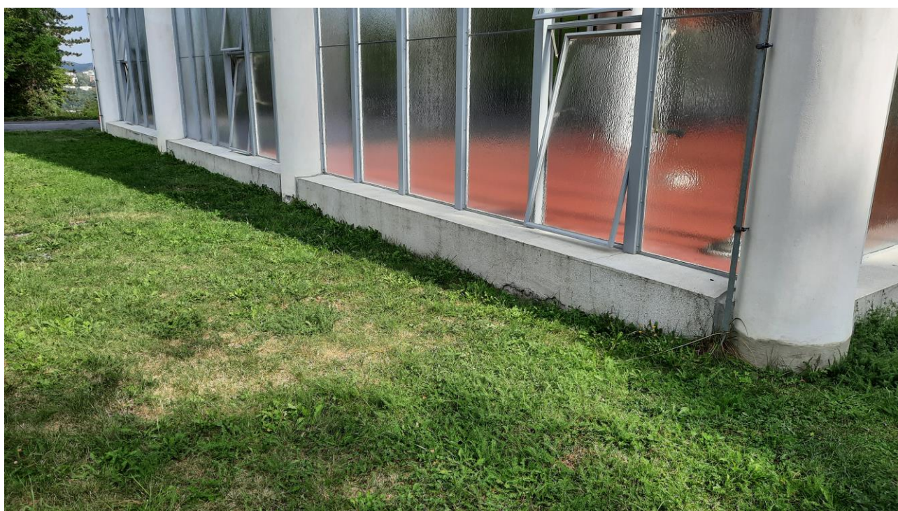
Obr.: Západní strana budovy
