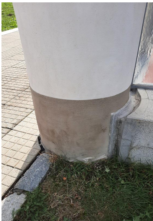
Obr.: Detail pravého rohového sloupu; východní strana
