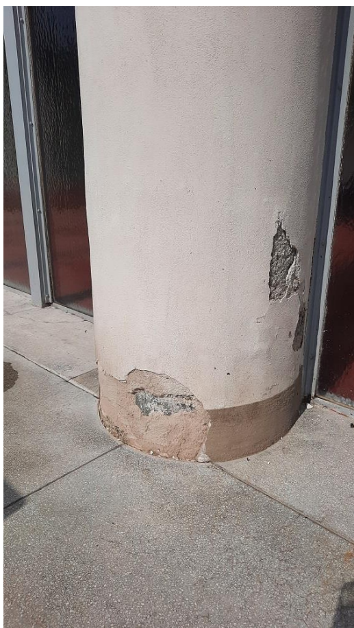
Obr.: Detail sloupu na jižní straně
