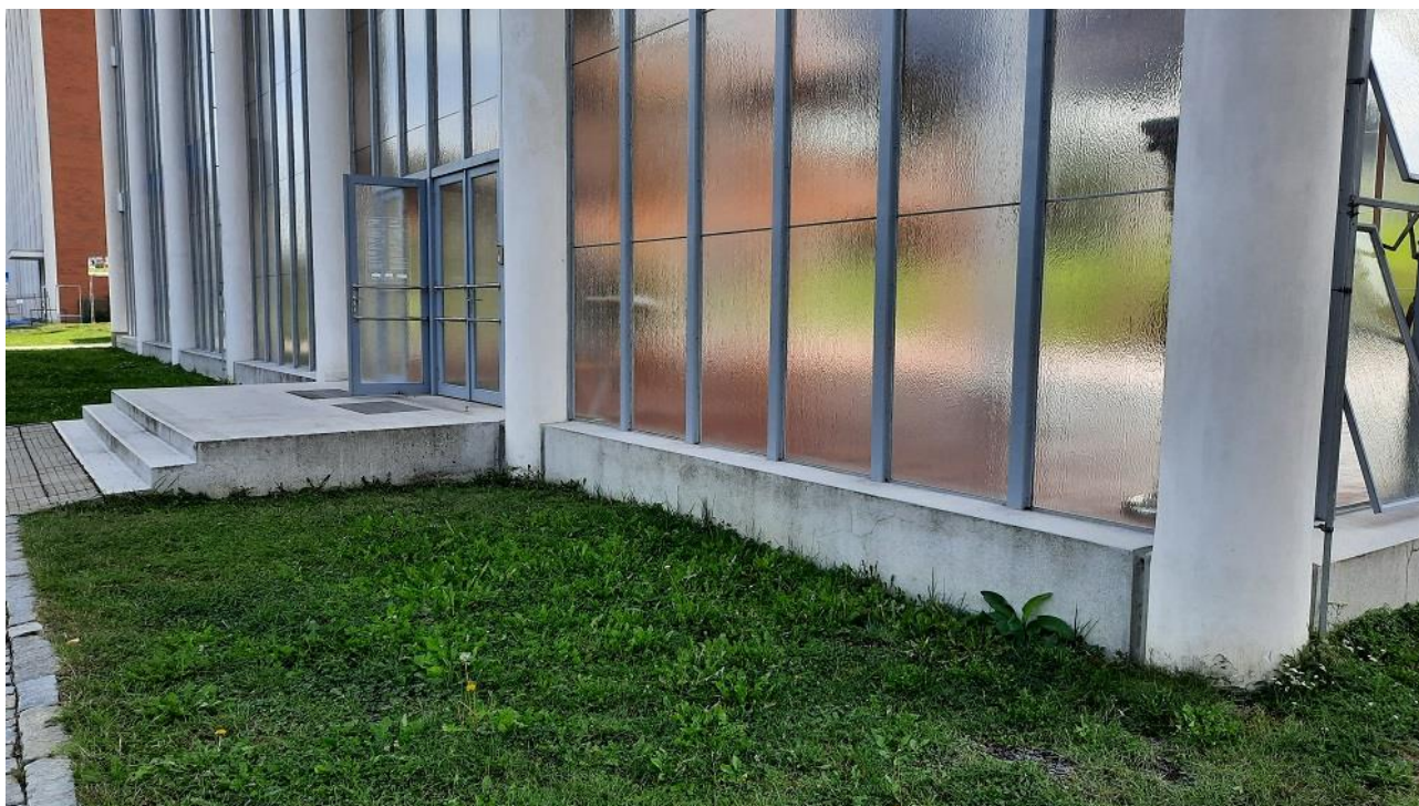
Obr.: Hlavní vchod ze severní strany budovy
