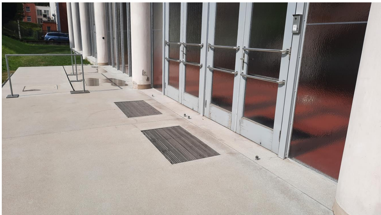
Obr.: Jižní strana budovy; sloupy na teracové podestě u zadního vchodu
