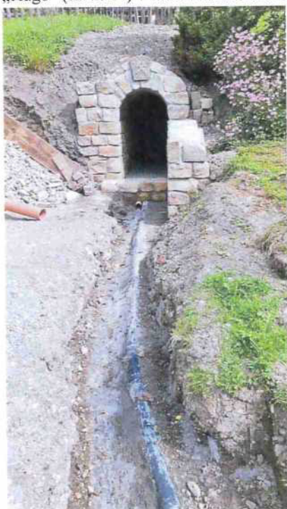
Stav na lokalitě během KD č. 2, detail ústí štolý Hugo
