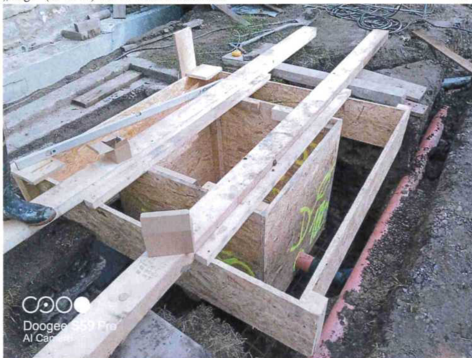
Stav na lokalitě – příprava betonáže jímky (máchadla), zdroj: Zhotovitel
