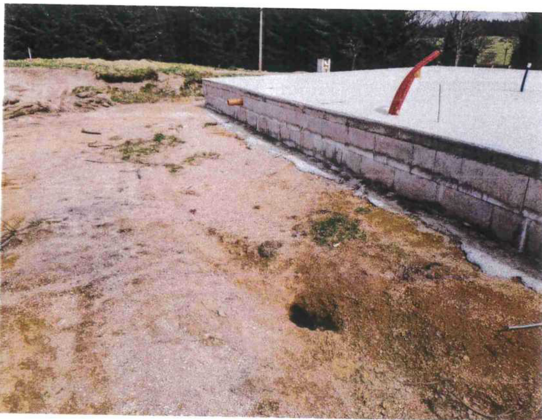
Foto č. 2 pokles (propad) terénu Přebuz (p. č. 785/10) po přejetí místa nákladním vozidlem
