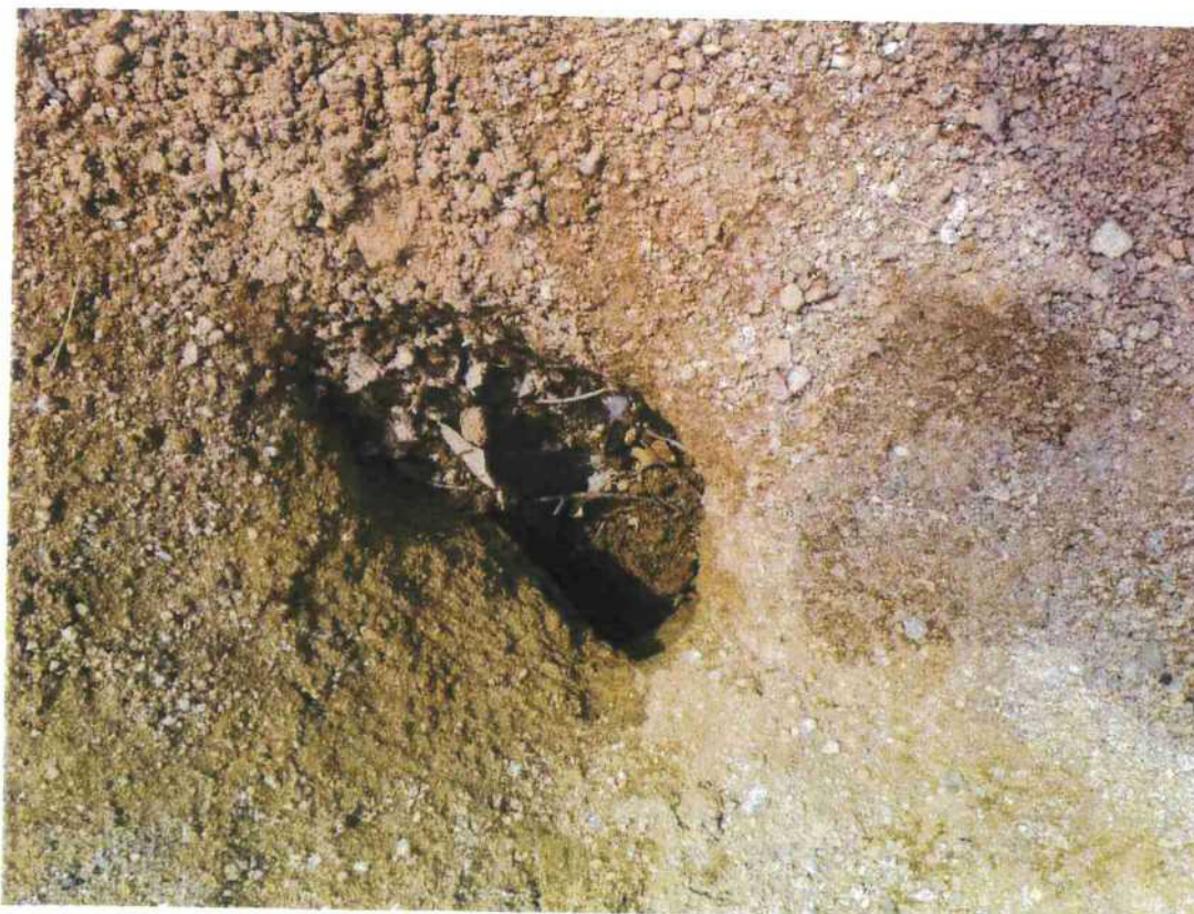
Foto č. 2 pokles (propad) terénu Přebuz (p. č. 785/10) po přejetí místa nákladním vozidlem
