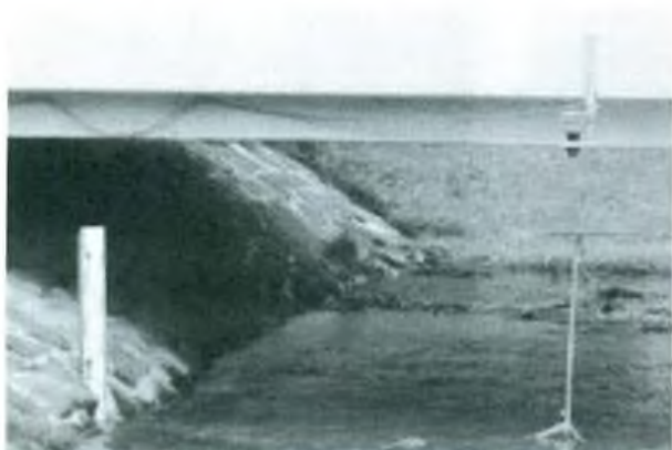
Obrázek 5: Nevhodné umístění čidla do průtočného profilu a zajištění přívodního kabelu; zdroj: výše uvedená metodická příručka MŽP
