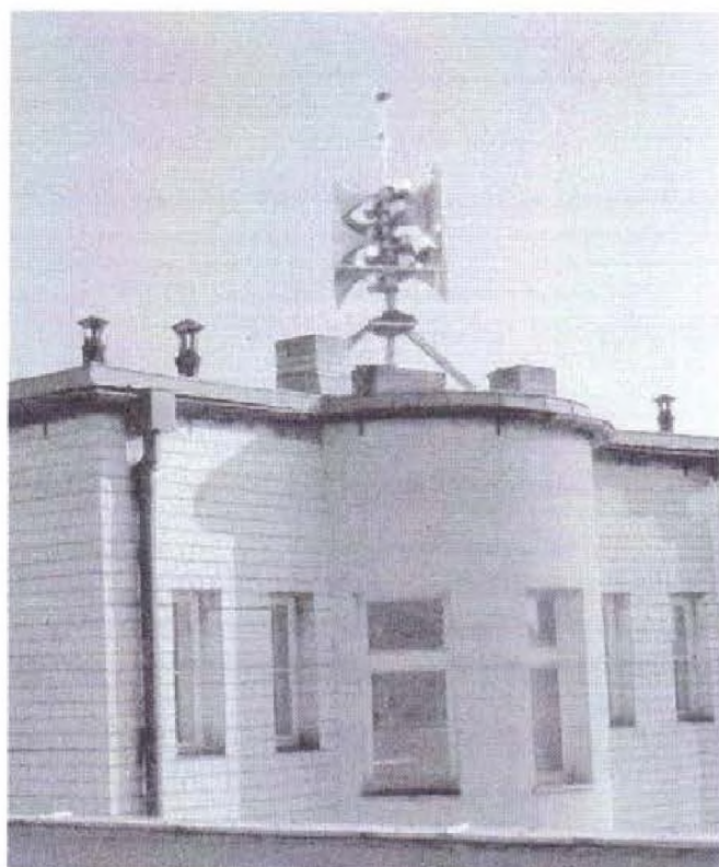
Obr. 4. Ukotvení na ploché střeše pomocí „čtyrnožky“.
