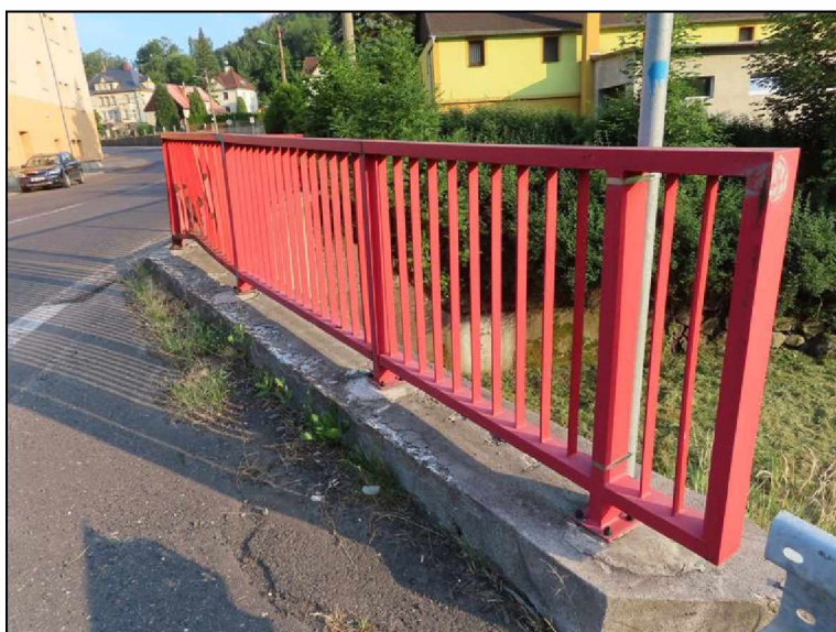
Pravá strana za OP1 Pravé rozšíření Zábradlí
