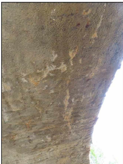
Pohled od OP1 PS Projevy zatékání - drobné výluhy
