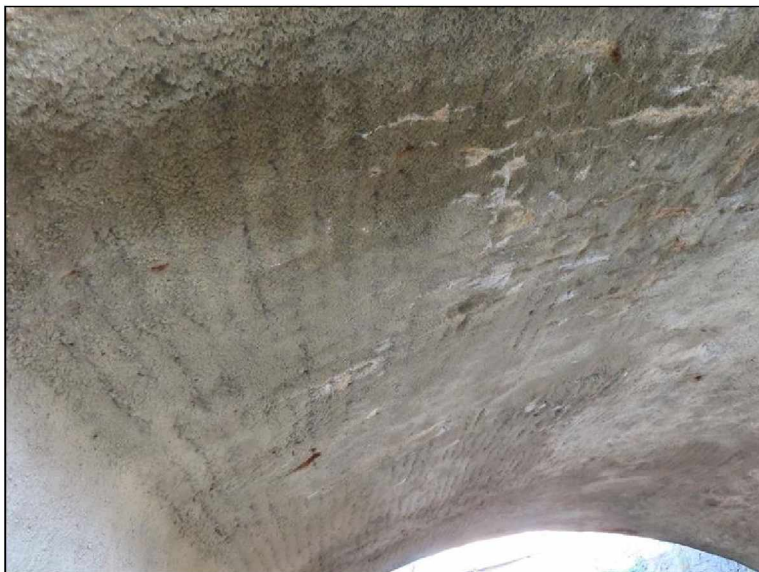
Pohled od OP1 PS Projevy zatékání - drobné výluhy
