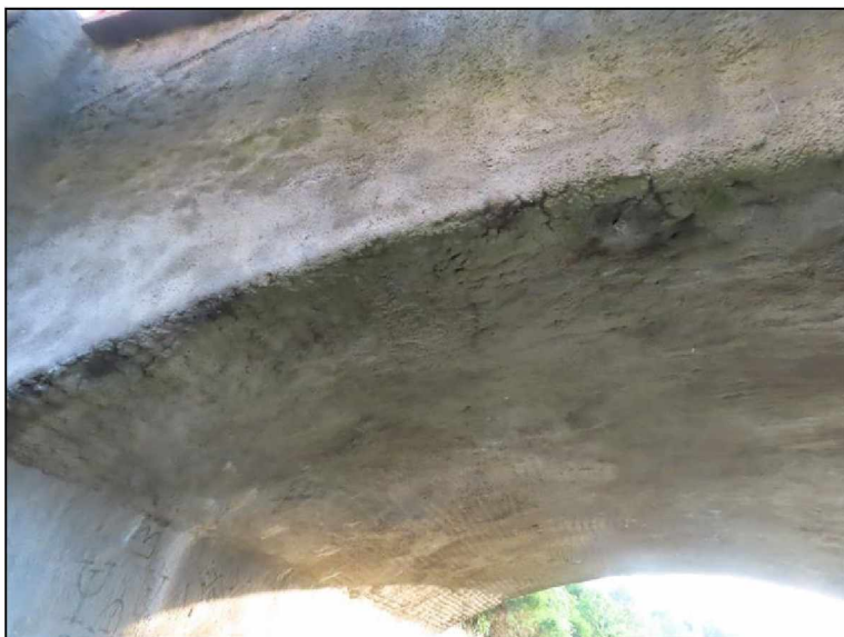
Pohled na OP2 zprava Průsaky podél svislé hrany a na přechodu klenby a dříku
