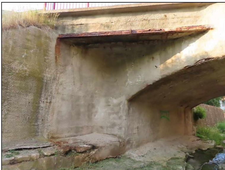
Pohled na OP1 zprava NK Pravé rozšíření
