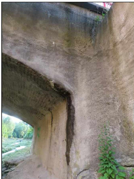
Pohled na OP1 zleva Projevy průsaků- mokré
