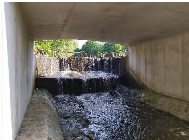
Obr. 2: Bezpečnostní přeliv – průchodnost pro vydru: Neprůchodný BP (vlevo) – svislá přelivná hrana výšky 1 m je nepřekonatelná pro vydru i pro většinu dalších živočichů. Zde je bariérový účinek navíc zvýšen předsazenou ocelovou lávkou s česlemi. Zvířata migrující podél vodního toku jsou nucená přebíhat přes frekventovanou silnici; vpravo - neprůchodný BP z pohledu vydry migrující proti proudu vodního toku. Vydra je v tomto případě schopná projít most pod silnicí, narazí ale na svislou zeď bezpečnostního přelivu, jehož bariérový účinek je navíc zvýšen kovovými česlemi. Zvíře nemá jinou možnost než se vrátit a pokusit se přeběhnout vrchem hráze rybníka s frekventovanou silnicí.
