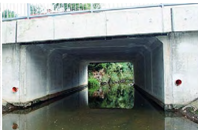
Obr. 48: Most, kde voda vyplňuje celou šířku mezi stěnami je při větší hloubce vody pro vydru neprůchodný – většina zvířat při migraci podél toku most nevyužije a přebíhá silnici horem
