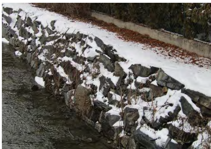
Obr. 25: Kamenná rovnánina (vlevo), zpřírodněná kamenná rovnánina (vpravo)
