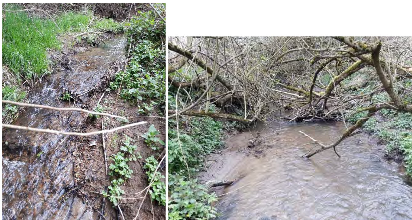
Obr. 30: Působení renaturačních procesů – vlevo překrytí úpravy sedimenty (vegetační tvárnice viditelné ve vzdálenější části snímku), vpravo odnos opevnění břehů betonovými prefabrikáty, úprava dna překrytá sedimenty, akumulace říčního dřeva v korytě a zarůstání koryta dřevinami
