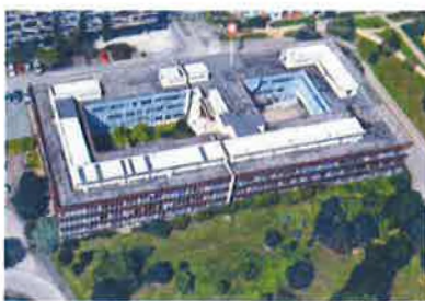
Poliklinika, Plaňanská 1, Praha 10. Supervize při odstraňování azbestových materiálů a usazeného azbestového prachu v rámci celkové rekonstrukce polikliniky.
