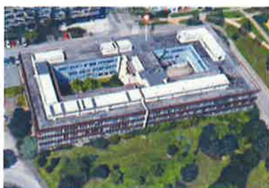
Poliklinika, Planánská 1, Praha 10. Supervize při odstraňování azbestových materiálů a usazeného azbestového prachu v rámci celkové rekonstrukce polikliniky.
