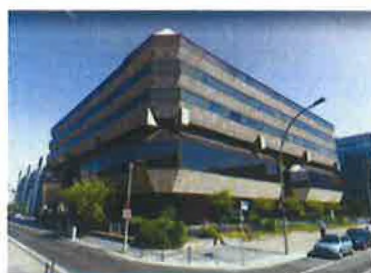
Budova Zastupitelského úřadu ČR v Berlíně. Komplexní průzkum výskytu azbestu včetně monitoringu prostředí.
