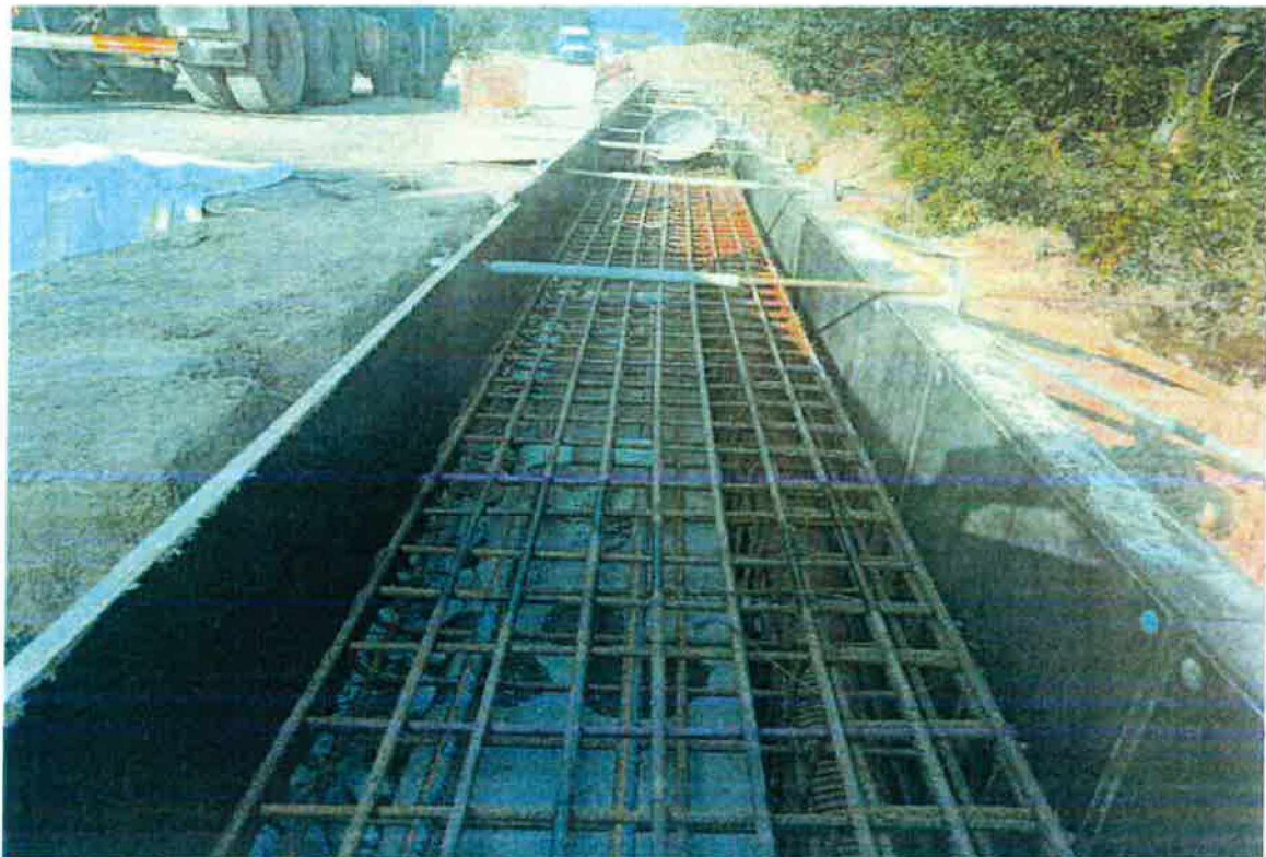
Bednění říms + vázání výztuže
