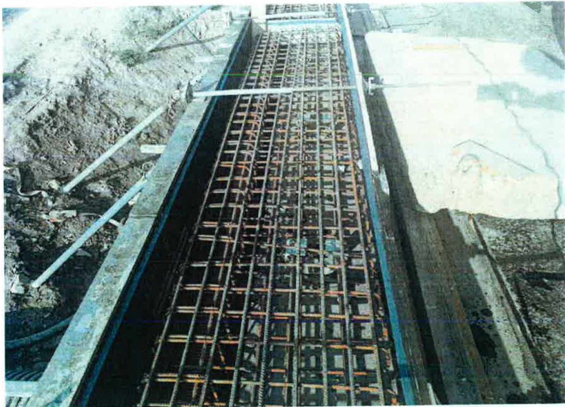
Bednění říms + vázání výztuže
