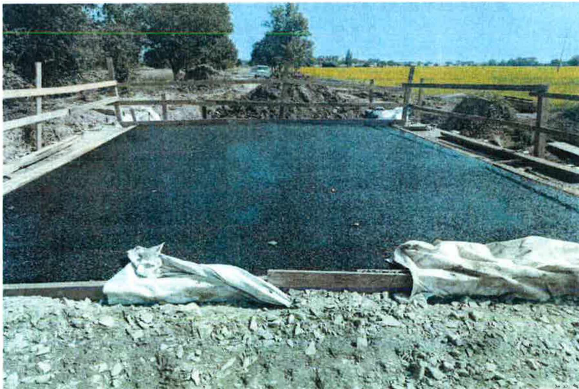
Zhotovení litého asfaltu tl. 35 mm
