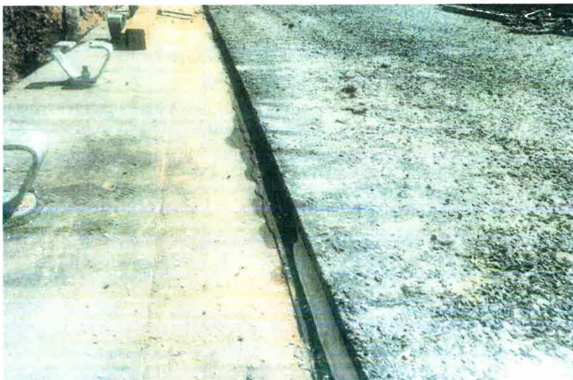
Litý asfalt tl. 35 mm + kotvy říms
