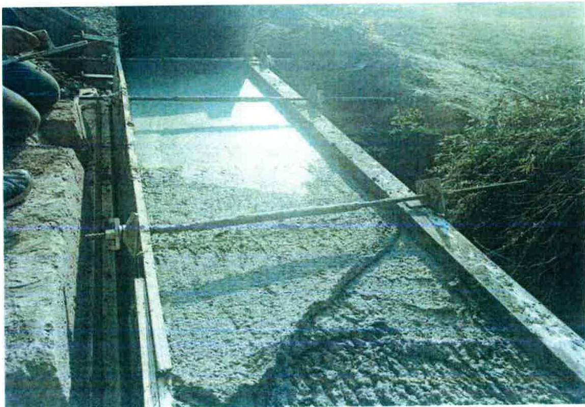
Betonáž říms
