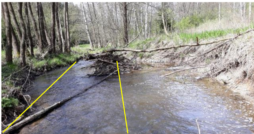
Obr. 31: Působení renaturačních procesů – odnos opevnění břehů kulatinou, výrazné nátrže při pravém i levém břehu a rozvolnění trasy boční erozí, vznik akumulčních tvarů dna a hromadění říčního dřeva; žlutými liniemi naznačena trasa původně opevněného koryta; zároveň se jedná o příklad břehové eroze v souvislosti s pozitivním působením renaturačních procesů (viz parametr 5), na snímku vpravo je stejný profil před cca 12 lety
