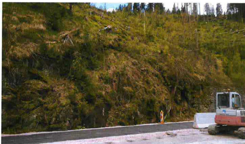
Pohled na řešený úsek svahu
