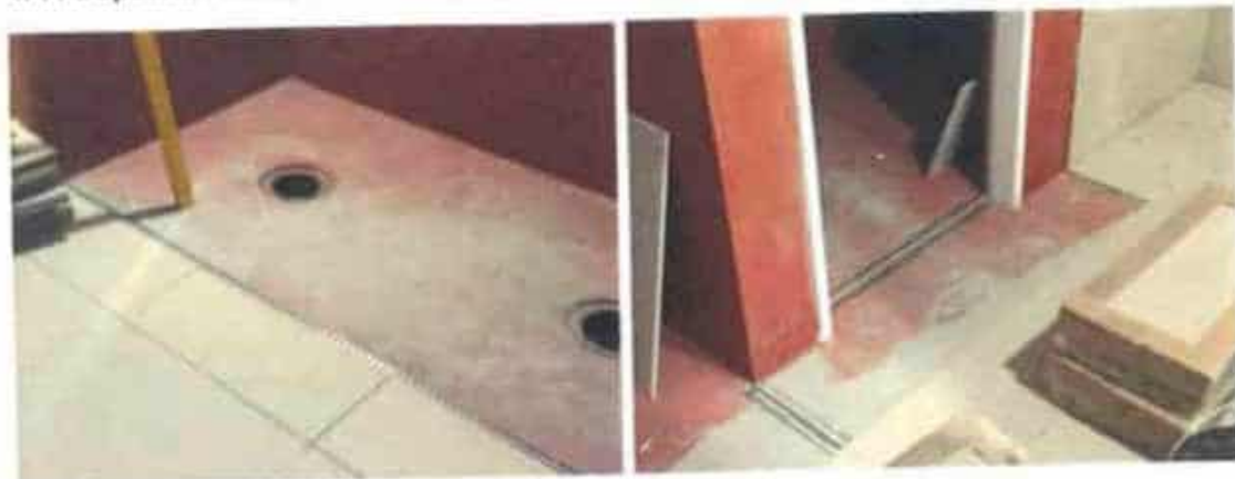
4/11 Doplnění dilatačních lišt ve koupelně
