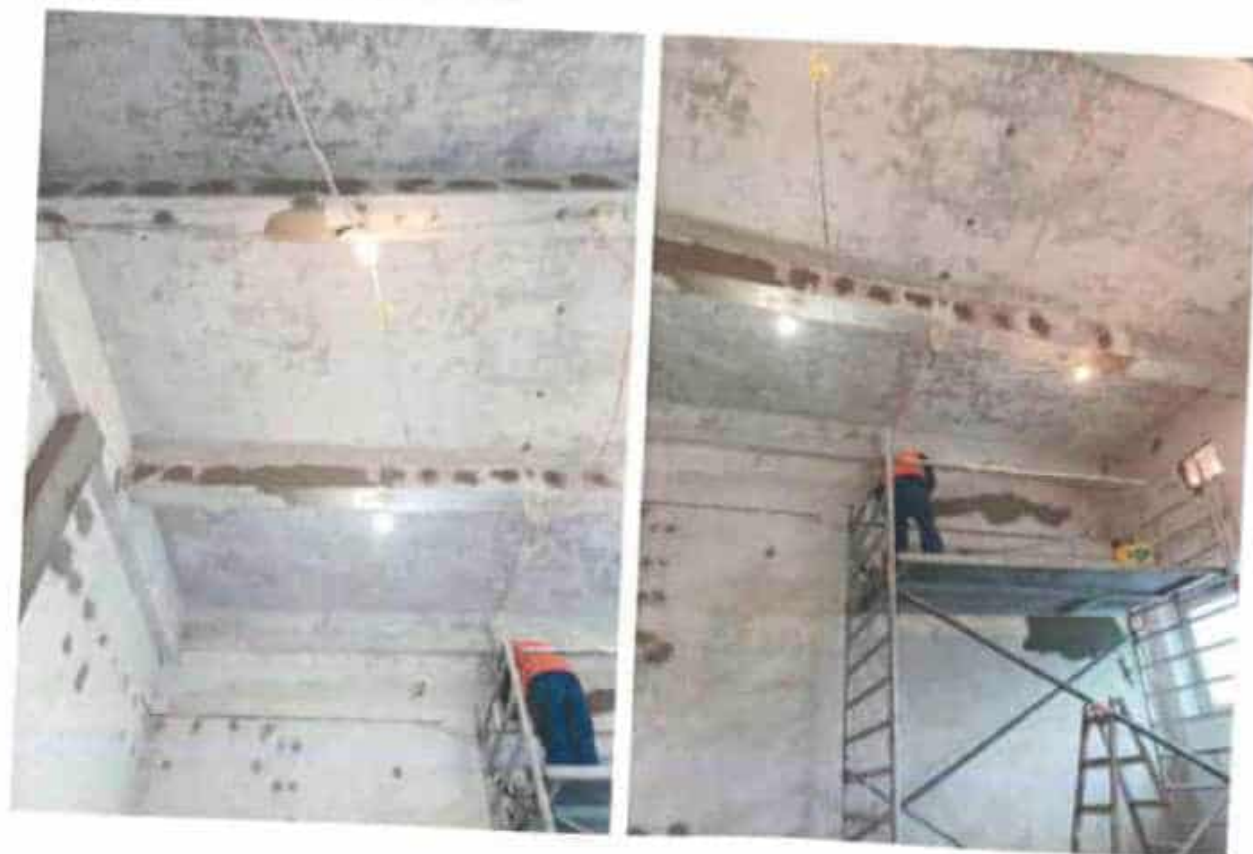
6/4 Sanace železobetonových vazníků
