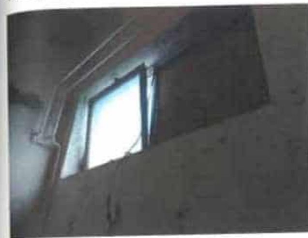
6/1 Výměna oken nad rámec PD
