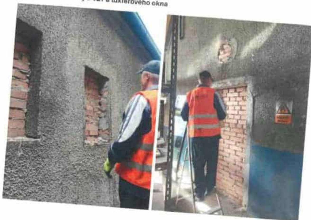
2/7 Zazdívka prostupů VZT a luxferového okna
