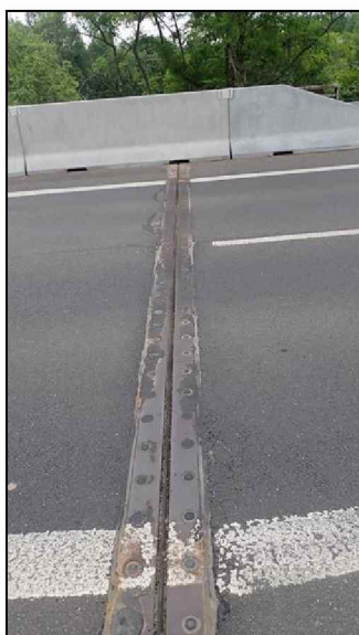
Pohled na MZ. PKO chybí. Lokální trhliny ve vozovce v okolí MZ. Těsnění zdá se neporušené
