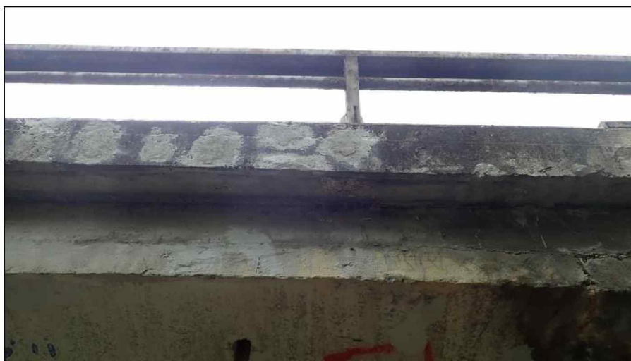
Lokálně asanovaná římsa. Ošetřena obnažená výztuž
