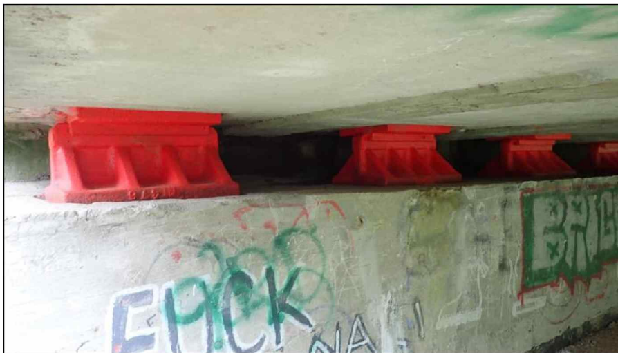
Nové ošetřená ložiska na OP2
