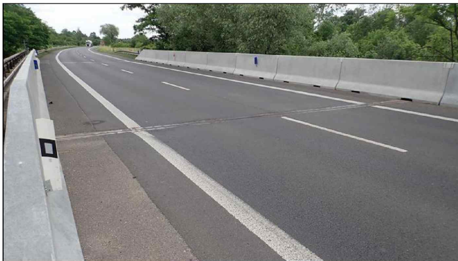
Pohled na MZ. PKO chybí. Lokální trhliny ve vozovce v okolí MZ. Těsnění zdá se neporušené
