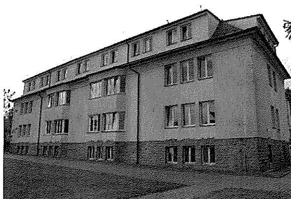
Obrázek 3 - Pohled II – hlavní budova
