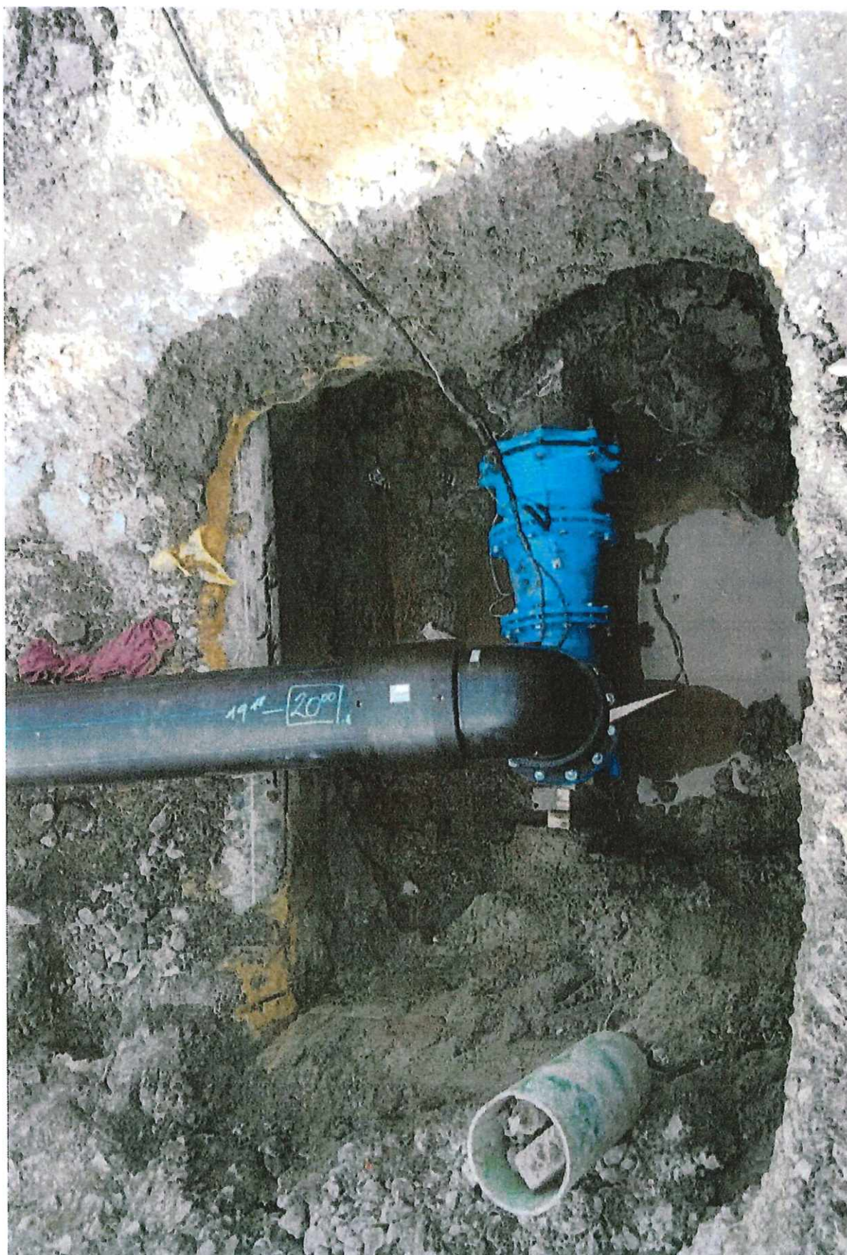
SO 302_SU – Suchovod – napojení KÚ
