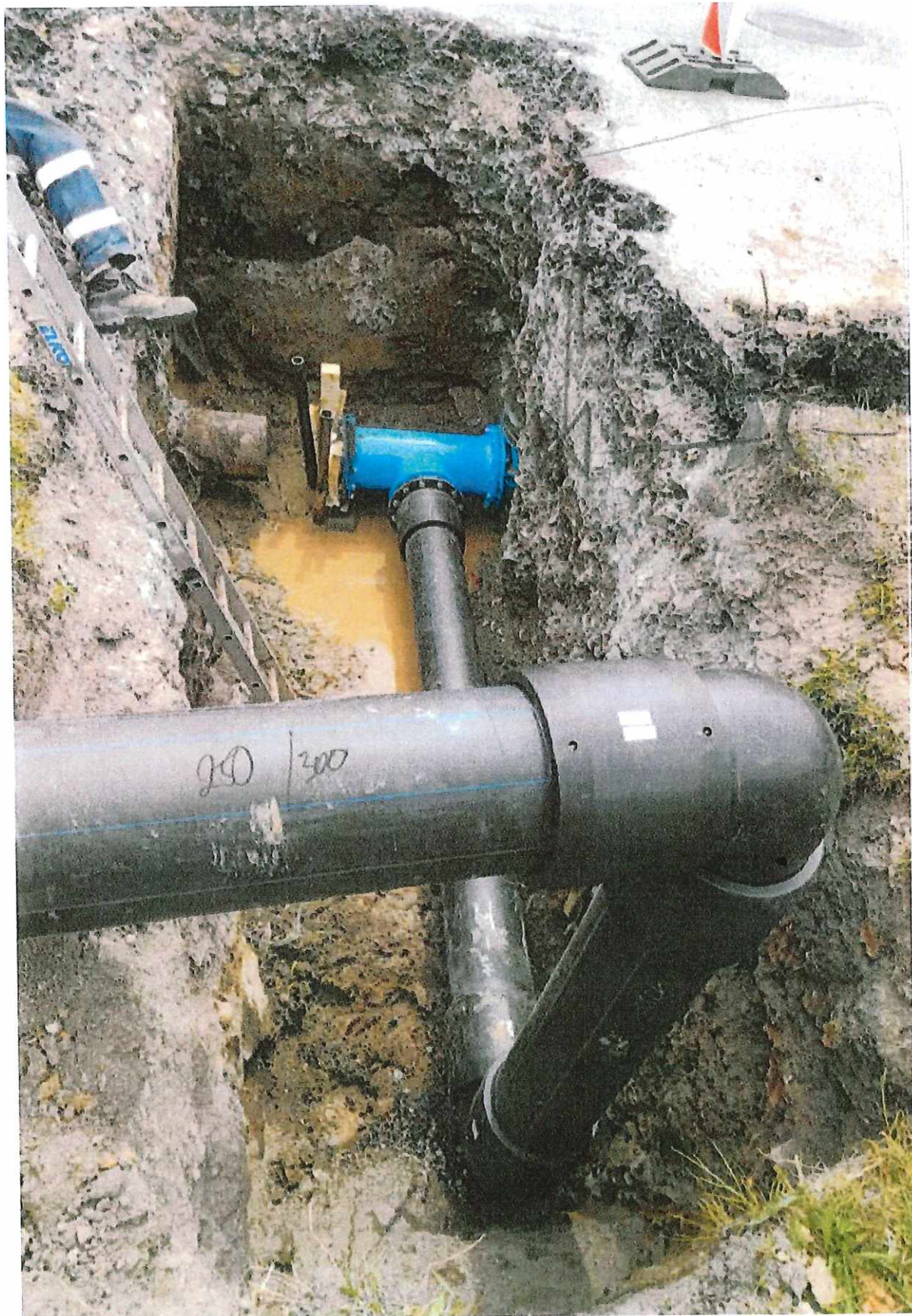
SO 302_SU – Suchovod – napojení ZÚ
