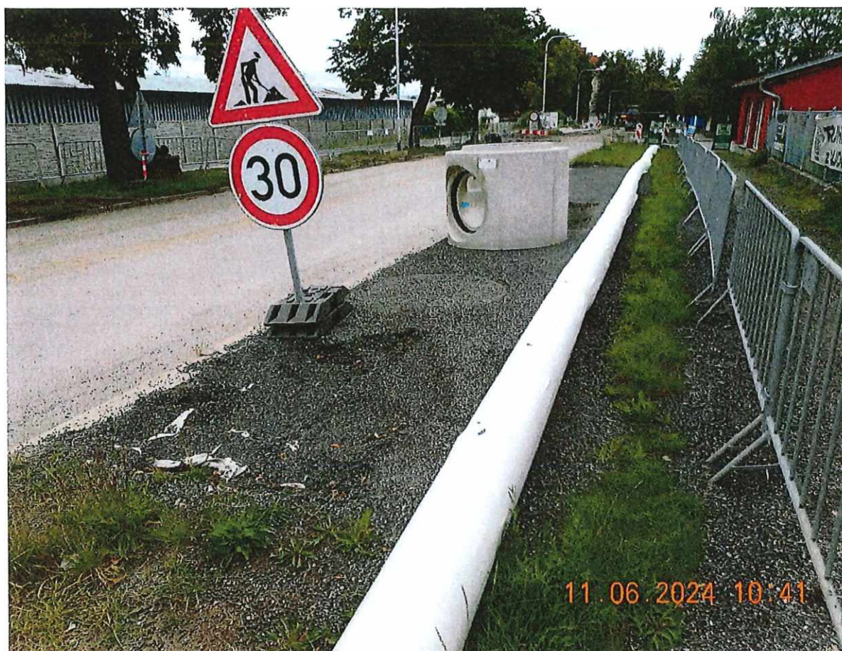
SO 302_SU – Suchovod – ochrana geotextilií
